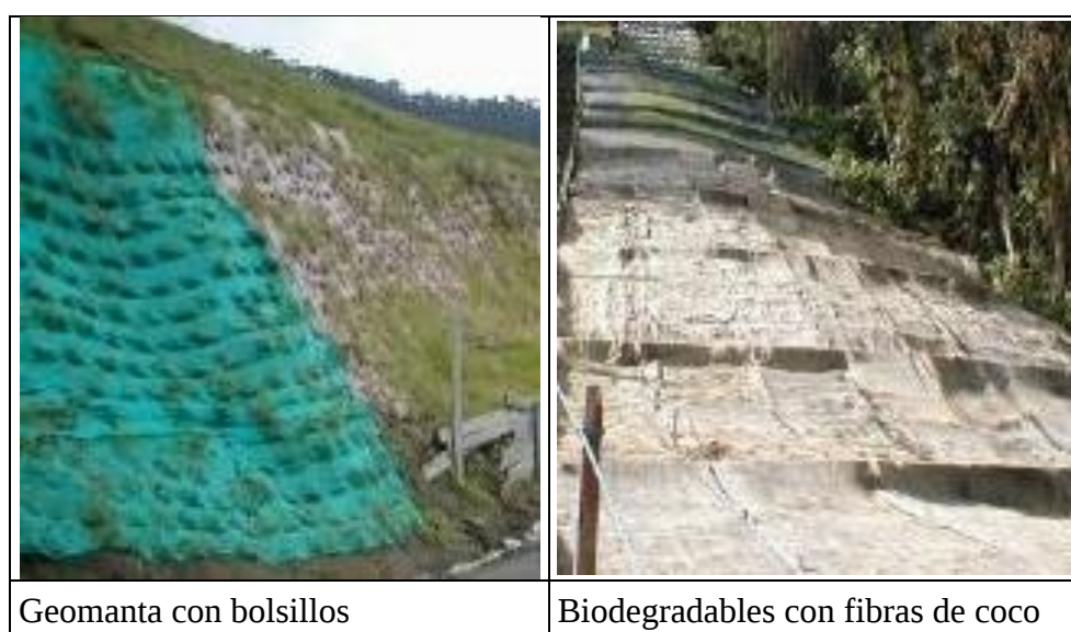
FIGURA No. 75: COLOCACIÓN DE GEOMANTO
