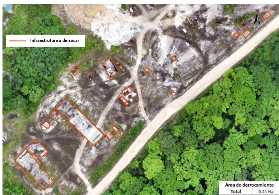
FIGURA No. 69: ÁREAS DE DERROCAMIENTO
