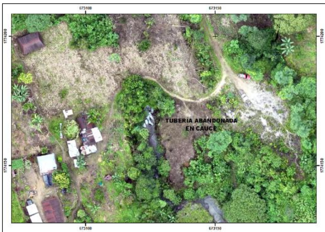
FIGURA No. 8: UBICACIÓN DE SUMIDERO Y RIESGO DE TAPONAMIENTO.
