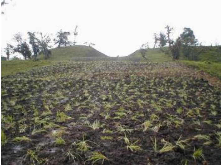
FIGURA No. 73: REVEGETACIÓN DE ÁREAS INTERVENIDAS CON ESQUEJES DE PASTOS
