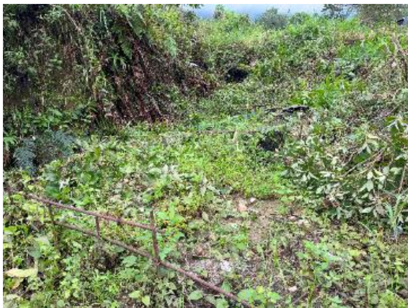
FOTOGRAFÍA No. 14 CAPTACIÓN - VARSOVIA. TUBERÍA GRP, QUEMADA.
