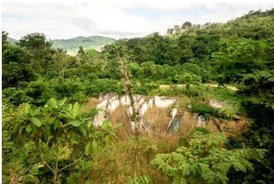
FOTOGRAFÍA No. 12 ZONA DE CASA DE MAQUINAS. VEGETACIÓN Y HIERROS EXPUESTOS.
