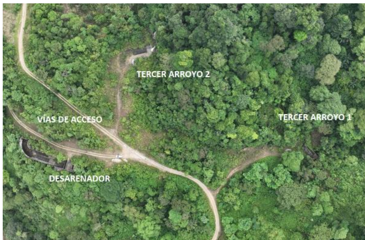
FIGURA No. 10: CAPTACIONES DEL TERCER ARROYO, DESARENADOR Y VÍAS DE ACCESO HABILITADAS.
