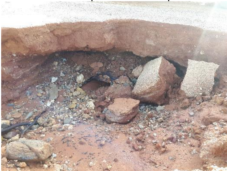
Foto 6-10 Aspecto del Relleno antrópico
