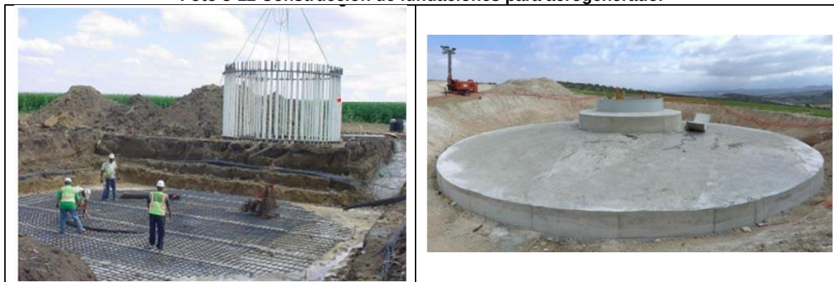
Foto 3-12 Construcción de fundaciones para aerogenerador
