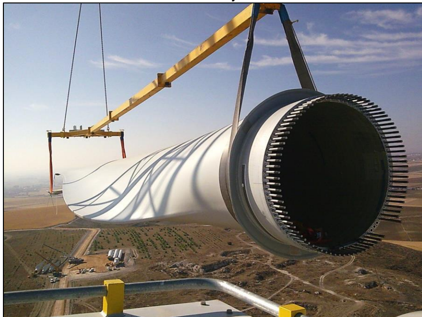
Foto 3-20 Desmontaje de una Pala
