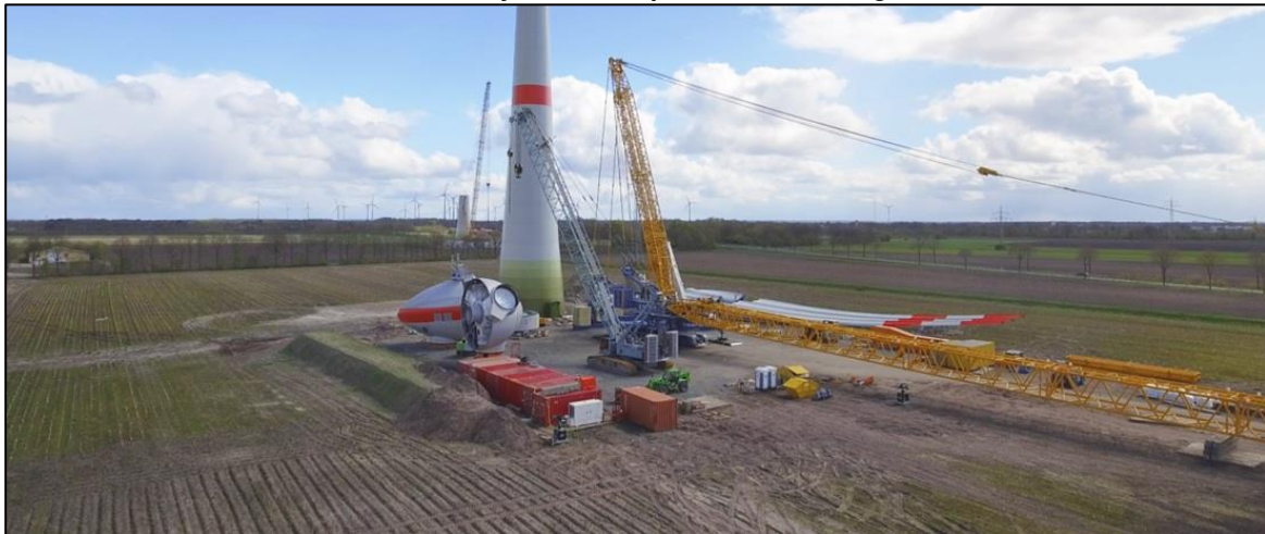
Foto 3-14 Ensamblaje de torres para de cada aerogenerador
