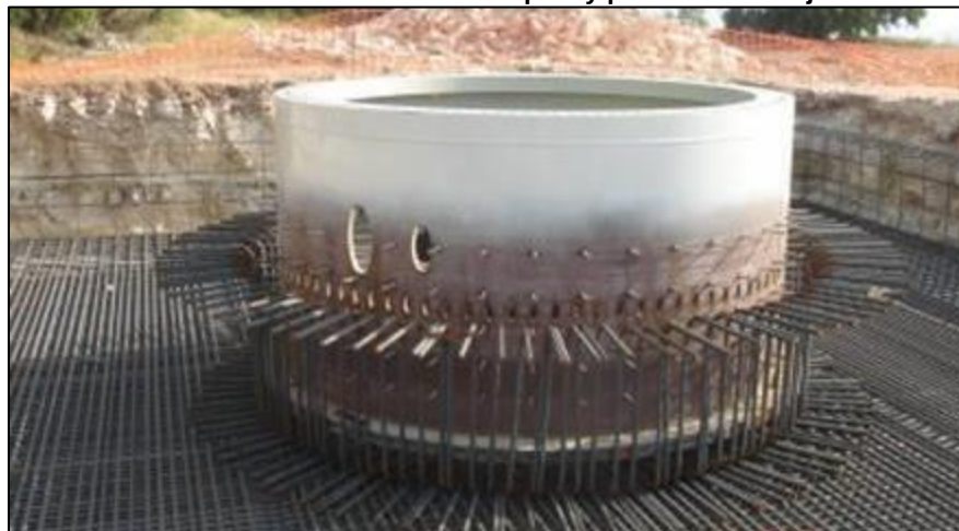
Foto 3-22 Armadura de una zapata y pernos de anclaje
