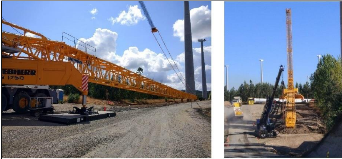
Foto 3-13 Área de ensamblaje de grúa en plataforma de cada aerogenerador
