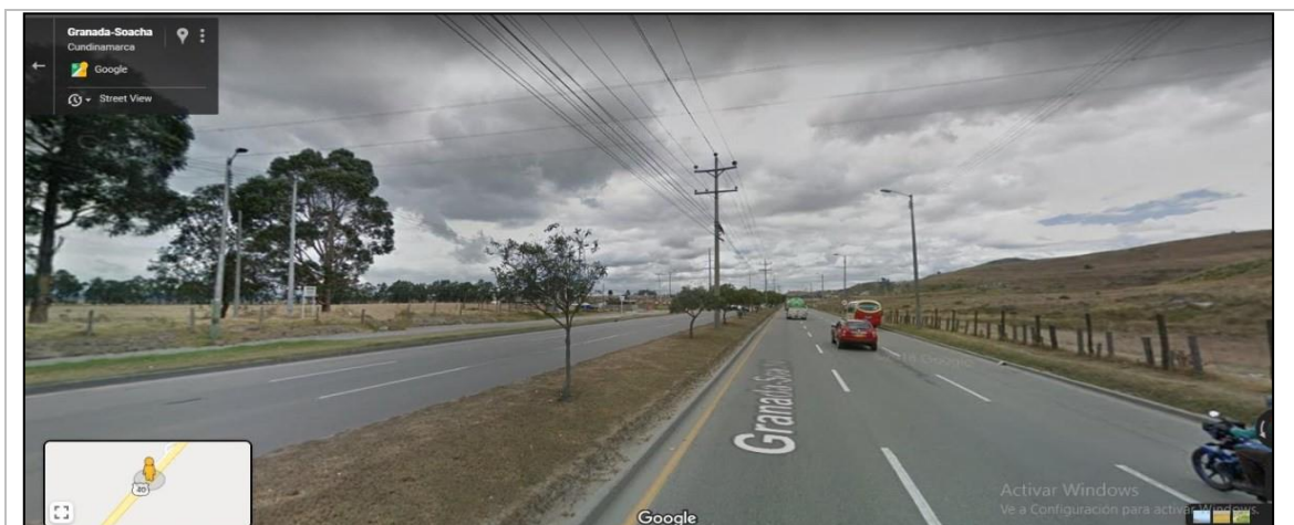
Figura 12-10. Ejemplo de línea de transmisión sobre separador de vía ubicado en la Ruta Nacional 40.
