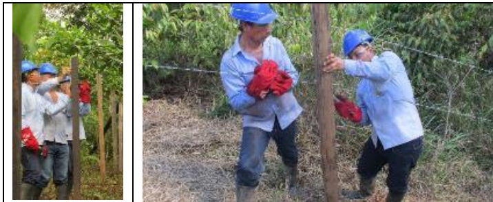
Fotografía. Templado y grapado de cercas.
