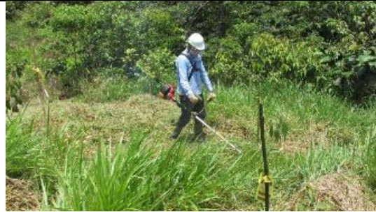
Fotografía 10.2 Limpia del área a rehabilitar
