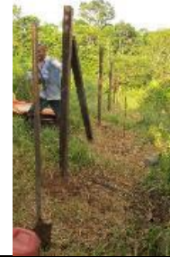
Fotografía. Ahoyado y trazado para instalación de postes de madera.
