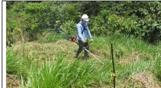
Fotografía Limpia del área a rehabilitar
