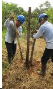
Fotografía. Ahoyado y trazado para instalación de postes de madera.
