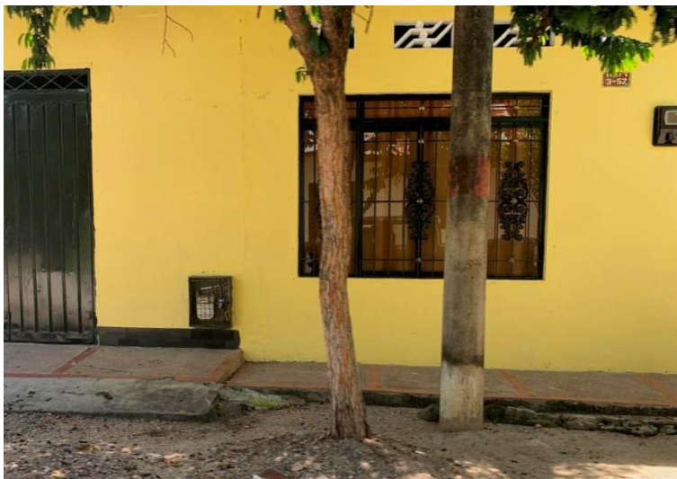
Foto 5.3-64 Vivienda con conexión a gas domiciliario -Piedras
