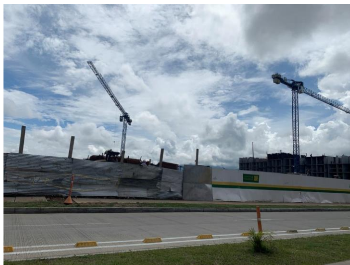
Foto 5.3-106 Actividades de construcción Arboleda del Campestre
