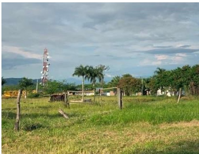
Foto 5.3-81 Torre de comunicación celular – Vereda Picalaña (sector rural)
