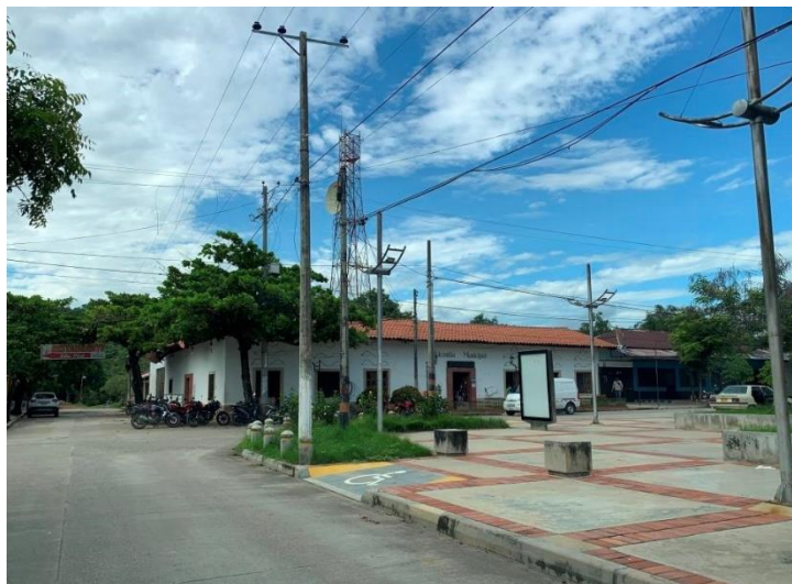
Foto 5.3-63 Redes eléctricas y de alumbrado público - Piedras
