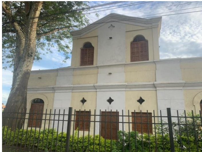
Foto 5.3-121 Antigua Estación del ferrocarril Barrio Picalaña
