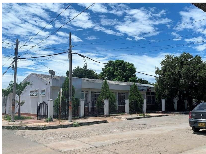
Foto 5.3-66 Hospital San Sebastián - Piedras
