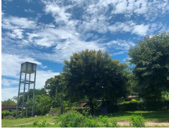
Foto 5.3-74 Tanque almacenamiento agua vereda Estación Doima
