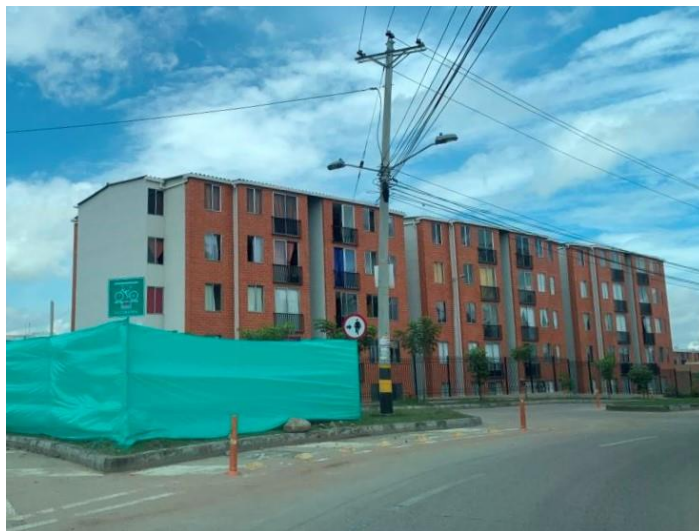
Foto 5.3-52 Construcción de apartamentos Arboleda del Campestre - Picaleña – Ibagué, Tolima
