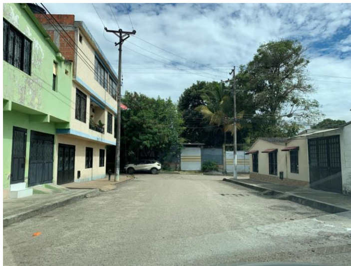
Foto 5.3-54 Redes eléctricas en zona urbana Ibagué
