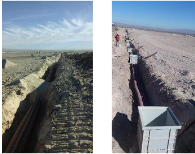
Fotografía 3.54. Trabajo de apertura de zanjas en planta fotovoltaica.
