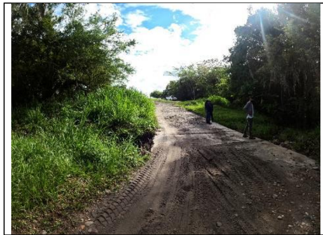
Fotografía 3.2-32 Vía V1 vista a superficie de rodadura Este: 4774509.822, Norte: 2045252. Fuente: H&J INGENIERÍA Y MEDIO AMBIENTE SAS (2021).
