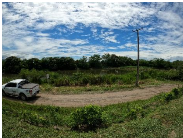
Fotografía 3.2-28 Red de baja tensión en el área de influencia
