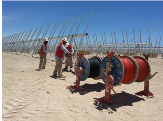
Fotografía 3.46. Tendido de cables eléctricos en Planta Fotovoltaica.
