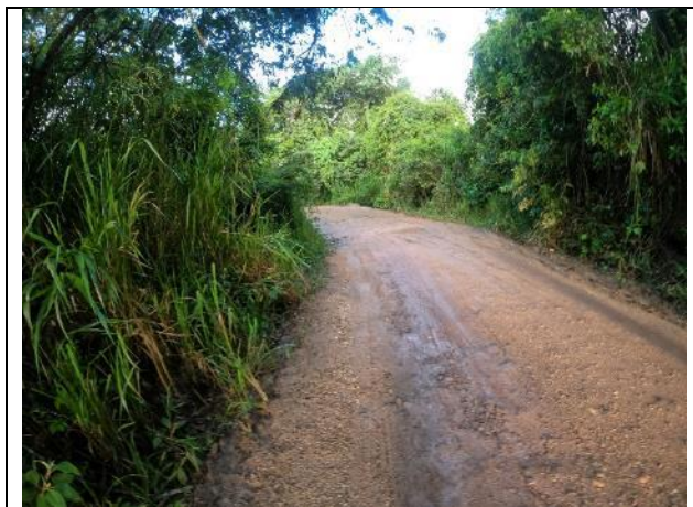
Fotografía 3.2-12 Vía VA-BA-D vista a superficie de rodadura
