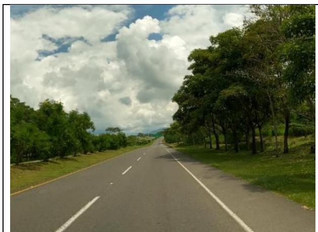
Fotografía 3.2-4 Vía AL-T-40-LTG vía doble calzada
