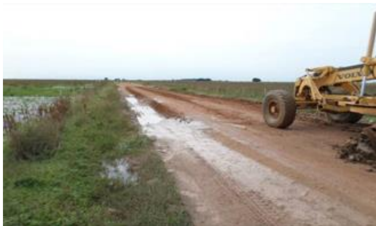
Fotografía 3.45. Perfilado y cuneteado de la vía.
