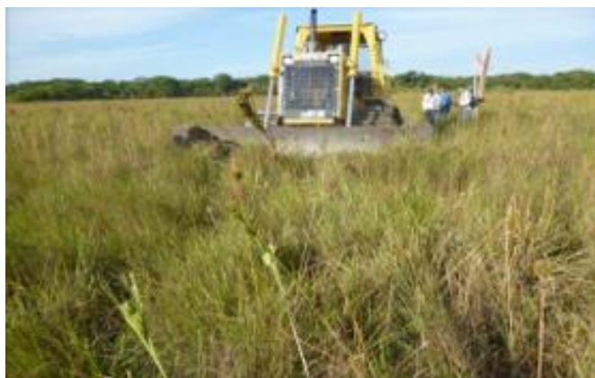
Fotografía 3.43. Inicio de descapote para apertura de vía.
