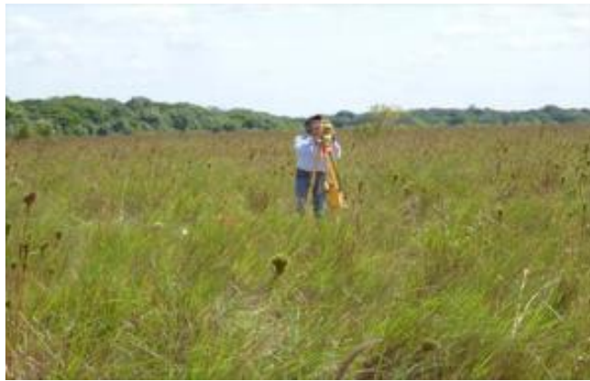
Fotografía 3.42. Localización e inicio del trazado de vía con topografía.
