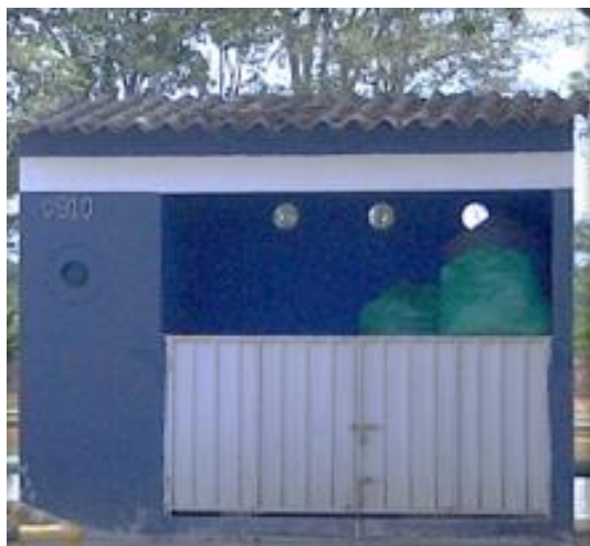
Fotografía 3.67. Caseta fija de residuos sólidos.
