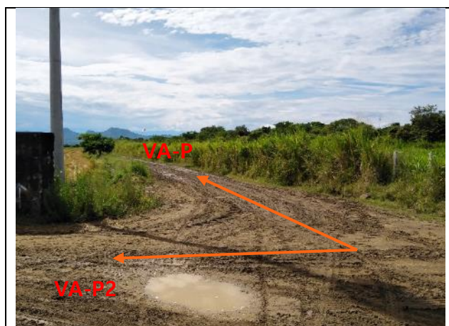
Fotografía 3.2-20 Ramal VA-P2 inicio tramo
