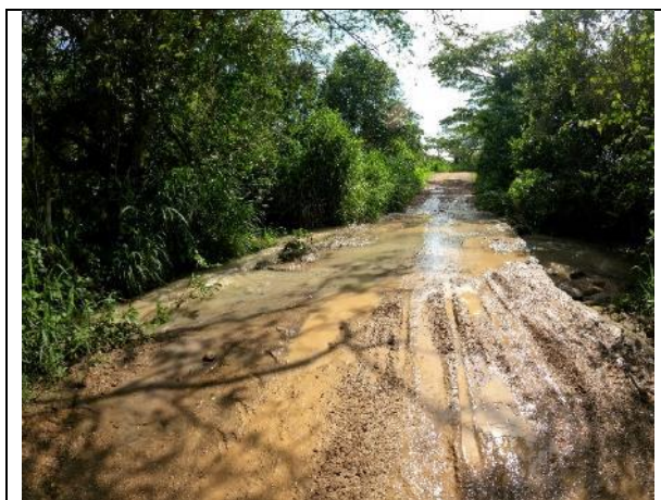
Fotografía 3.2-21 Ramal VA-P2 vista general
