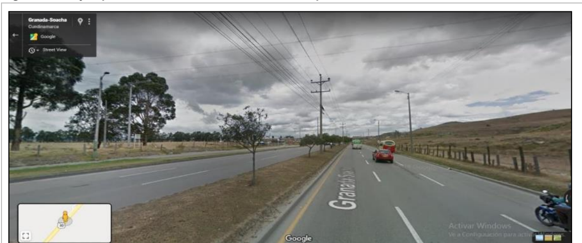
Figura 3.61. Ejemplo de Línea de Transmisión sobre separador de vía ubicado en la Ruta Nacional 40.
