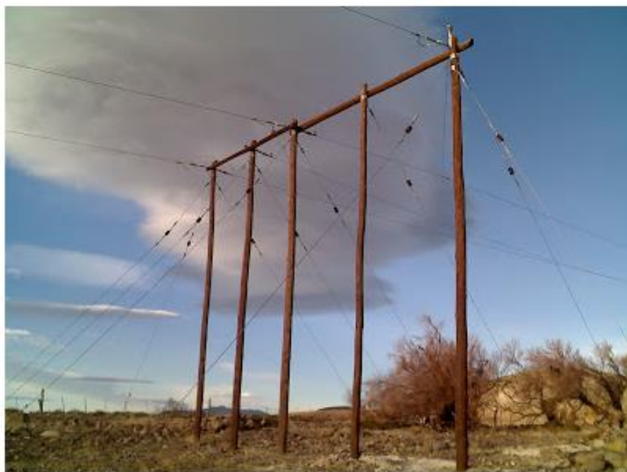
Fotografía 3-60 Pórticos provisionales para el tendido de cables en cruce de cuerpos de agua
