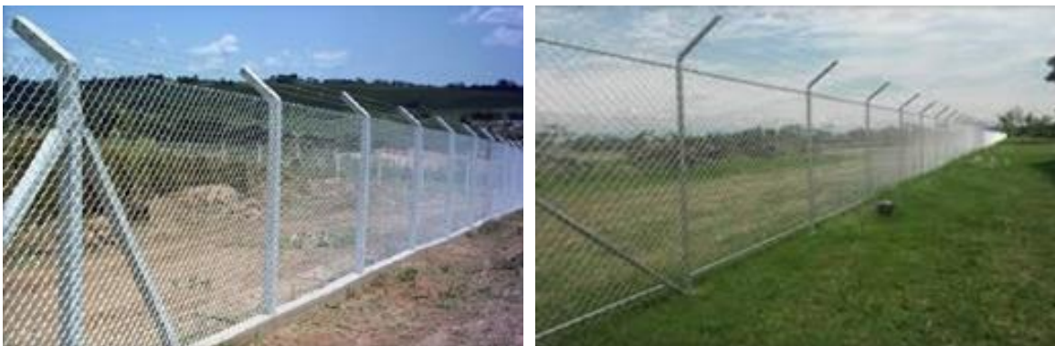
Fotografía 3.52. Cerramiento tipo construido en malla eslabonada.
