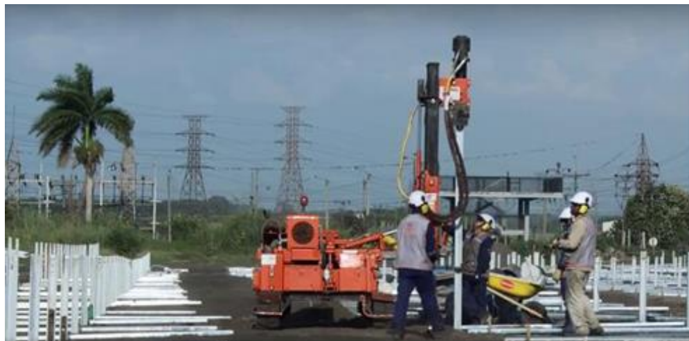
Fotografía 3.55. Hincado de estructuras para el montaje de paneles.
