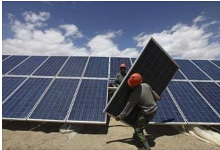
Fotografía 3.56. Montaje de paneles solares.
