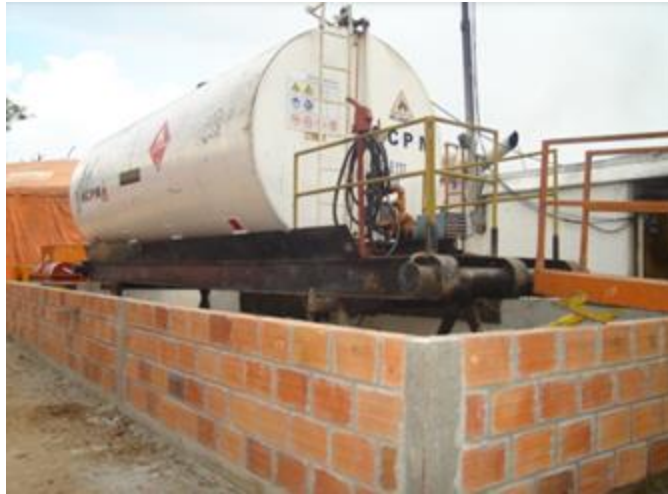
Fotografía 3.65. Dique tipo en mampostería y piso en concreto.
