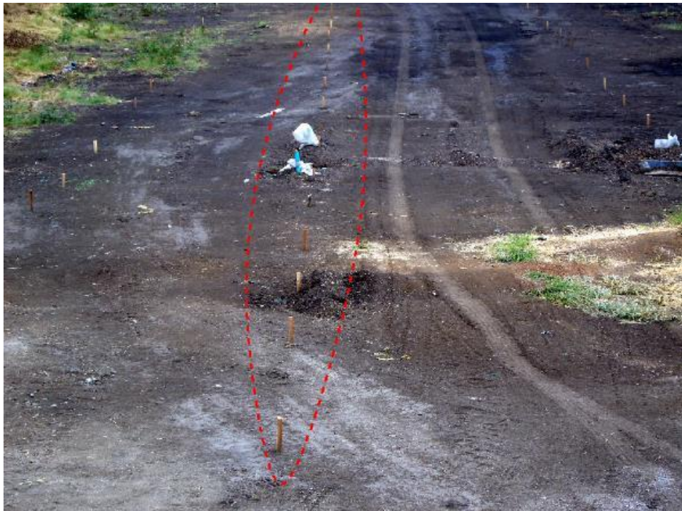
Fotografía 3.47. Plantillado y replanteo.
