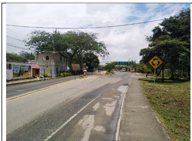
Fotografía 3.2-9 Vía AL-T-40-TLC vista cambio de calzada sencilla a doble
