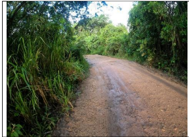
Fotografía 3.2-30 Vía VA-BA-D vista a superficie de rodadura
