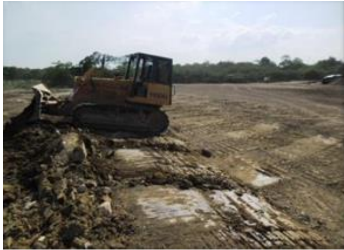
Fotografía 3.49. Corte y relleno.
