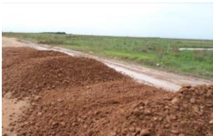
Fotografía 3.44. Perfilado y conformación de vía. Fuente: OPERADORA SHANGRI-LA S.A.S. E.S.P. (2021).
