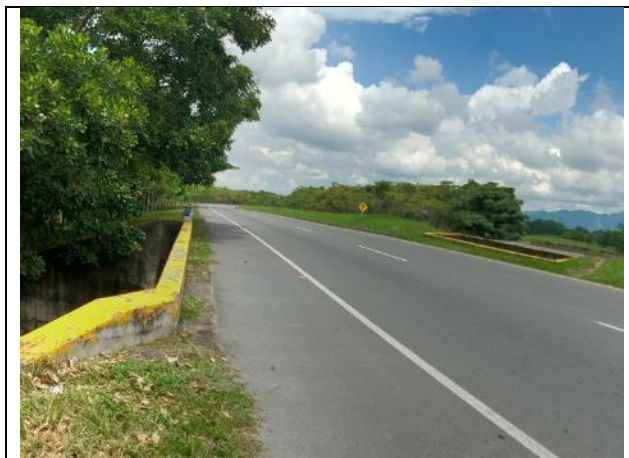
Fotografía 3.2-7 Vía AL-T-40-LTF estructura hidráulica
