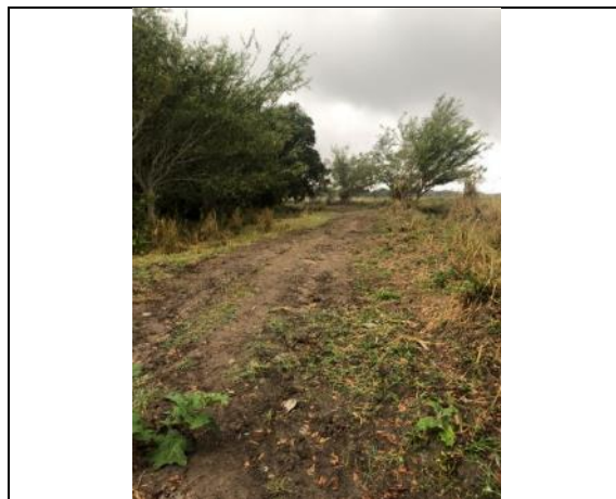
Fotografía 3.2-18 Ramal VA-P1 vista a superficie de rodadura
