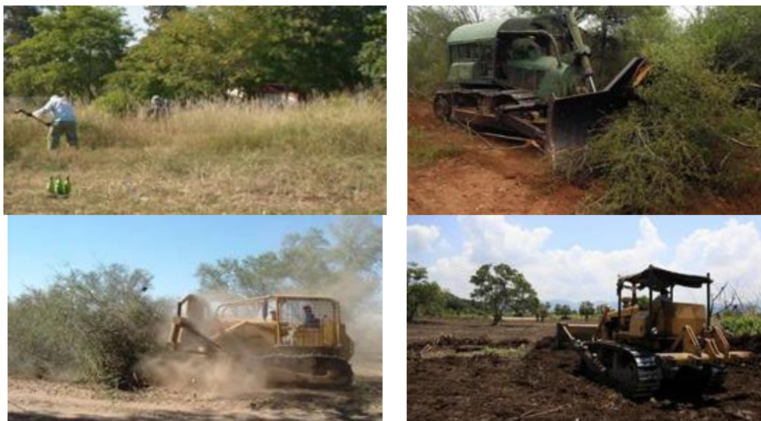
Fotografía 3.48. Limpieza y descapote para la adecuación del terreno.
