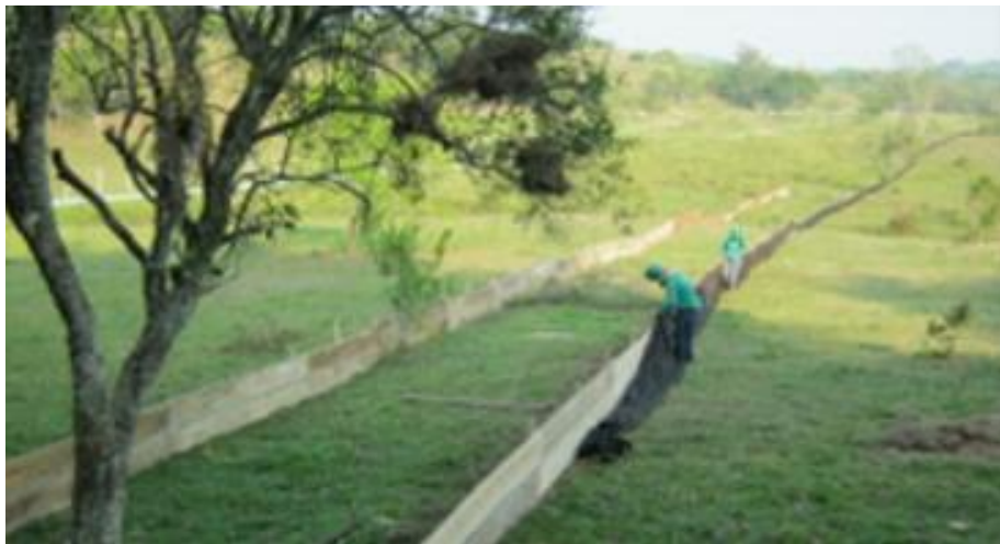
Fotografía 3.57. Sistema de barreras permeables tipo para retención de sólidos.
