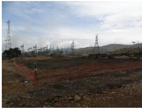
Fotografía 3.50. Compactación del terreno. Fuente: OPERADORA SHANGRI-LA S.A.S. E.S.P. (2021).
