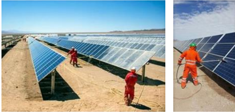
Fotografía 3.61. Limpieza de paneles.
