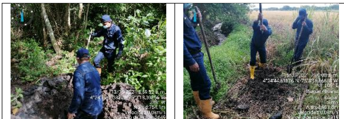
Fotografía 2.5-1 Apertura de calicatas y cajuelas área de estudio
