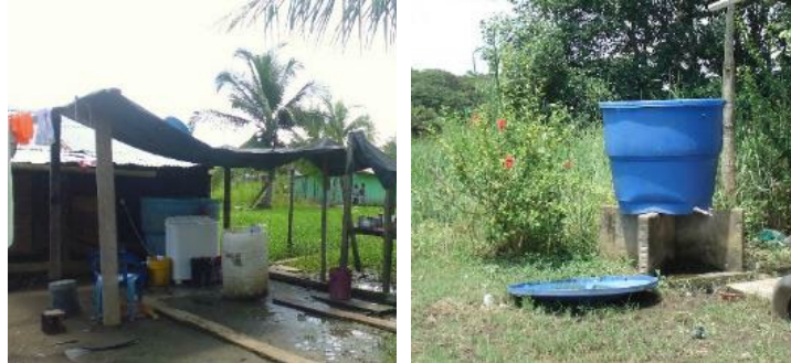
Fotografía No. 5.17 Sistema de recolección de agua en el asentamiento el Canal
