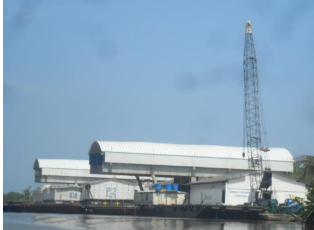
Fotografía No. 5.26 Zona de embarcadero de la empresa Banacol sobre el canal de Nueva Colonia
