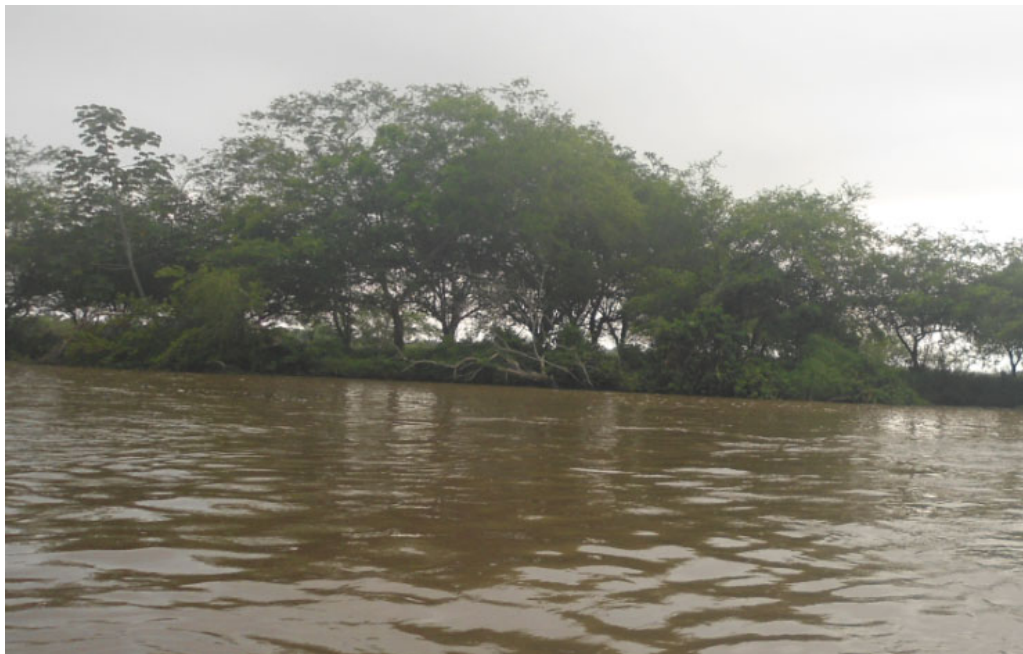
Fotografía No. 5.2 Dique sobre la margen derecha del río León. Fuente: Aqua & Terra Consultores Asociados S.A.S., 2015
