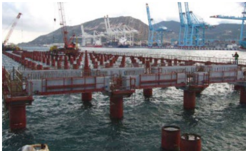
e. Vigas instaladas
