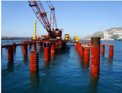
c. Plataforma metálica y la grúa instalada
