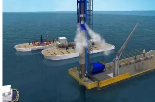
b. Hincado de pilotes
