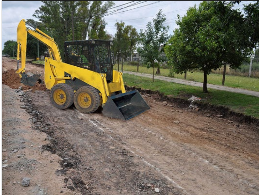
Fotografía No. 3.2. Excavación de la explanación y descapote
