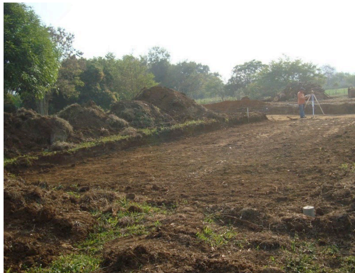
Fotografía No. 3.1 Desmote y limpieza Fuente: PIO SAS, septiembre 2015.
