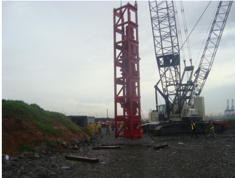
Figura No. 3.25. Martillo DELMAG y grúa Fuente: DC-PORT, noviembre de 2014.7
