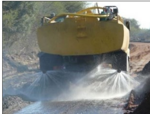
Fotografía No. 3.5. Humectación del material de sub rasante cuando está muy seco
