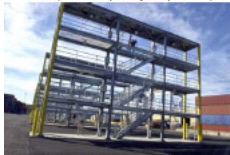
Racks de almacenamiento de contenedores refrigerados
