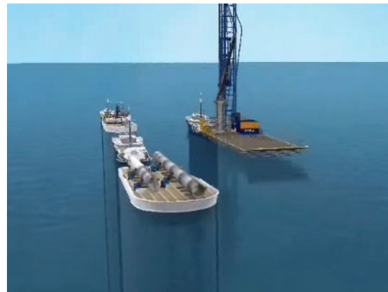
Figura No. 3.23. Anclaje de barcazas y ubicación y transporte de pilotes
