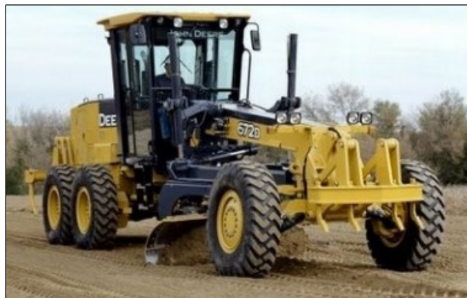
Fotografía No. 3.6. Aireación del material de sub rasante cuando éste tiene exceso de humedad
