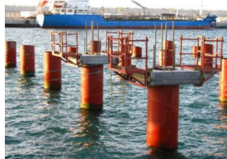
d. Capitel o anillo prefabricado instalado en el pilote
