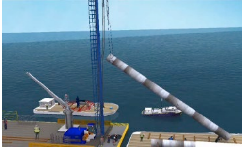
a. Colocación del pilote en posición para ser hincado
