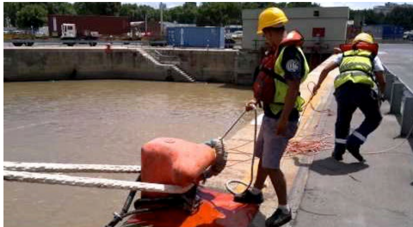
Fotografía No. 3.3. Bita instalada en un muelle Fuente: PIO SAS, septiembre de 2015.
