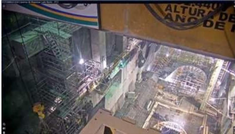
Figura 20: Trabajos en grúas aéreas móviles, soportes de rieles y rieles
