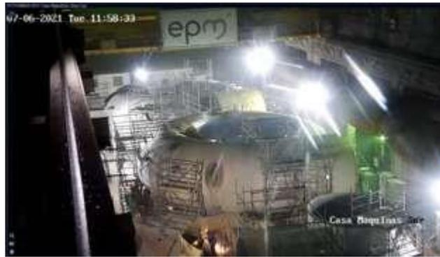
Figura 37: Cajas en espiral de la unidad 1 y en el fondo de la unidad 2
