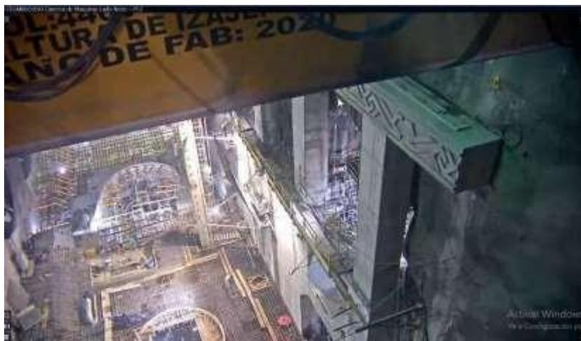
Figura 21: Rieles de desplazamiento de la grúa aérea completados
