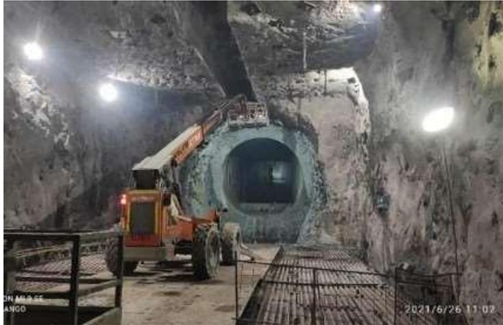
Figura 32: Cimentación del monorriel para la instalación de la tubería forzada 1
