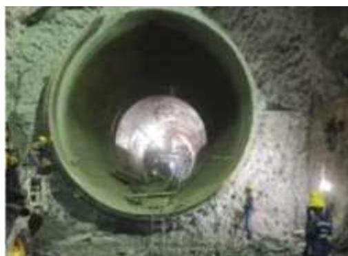
Figura 34: Retirada de hormigón alrededor del revestimiento de acero existente del codo inferior de la unidad 1
