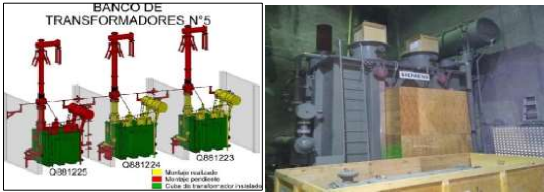
Figura n.º 11: Avances en la instalación de los transformadores al momento de la inundación
