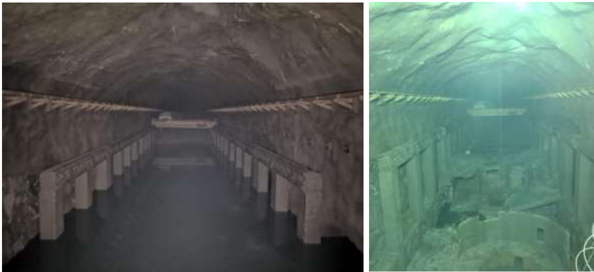
Figura n.º 6: Caverna de la sala de máquinas; febrero de 2019 (izquierda) y marzo de 2019. Se conserva la geometría fundamental.
