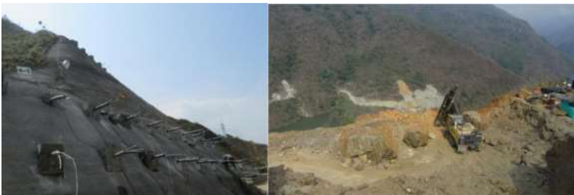
Figura n.º 13: La parte superior del desprendimiento en el “El Romerito”, en tratamiento con hormigón proyectado y anclajes. Excavación escalonada en la fotografía de la derecha.
