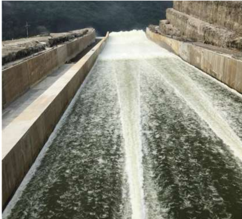
Figura n.º 17: Aliviadero en funcionamiento
