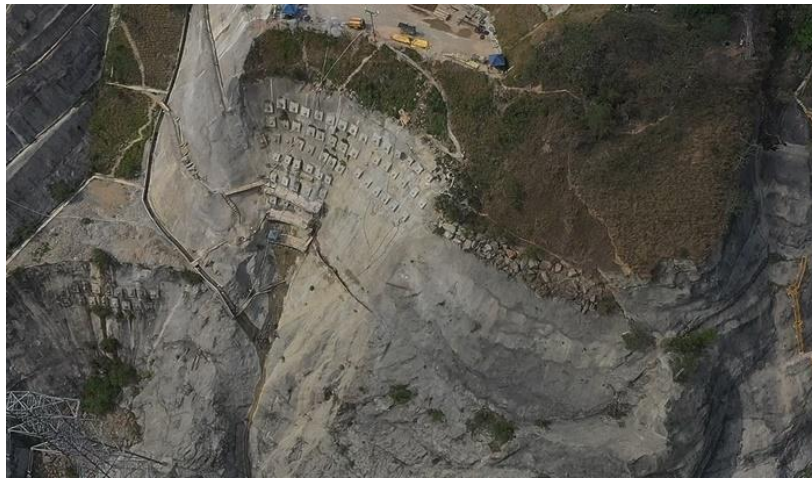
Figura 52: Las obras de estabilización [patio de maniobras en la esquina inferior izquierda, archivo]
