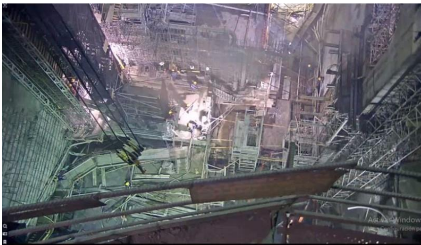
Figura 46: Obras civiles en la zona de la sala de control norte
