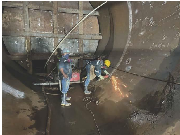
Figura 54: Codo inferior, reparación del revestimiento de acero
