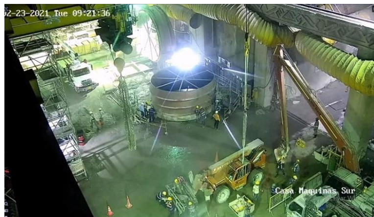
Figura 44: Muelle de carga y túnel de acceso visto desde la sala de máquinas sur
