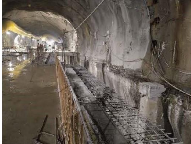
Figura 39: Obras civiles en curso en la galería de cables antes de la instalación de bandejas portacables y cables
