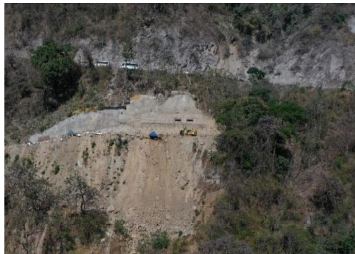
Figura 37: Obras en curso para refuerzo de las pendientes
