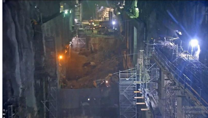
Figura 43: Demolición de hormigones de las unidades 3 y 4
