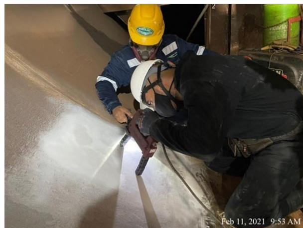
Figura 55: Codo inferior, prueba de revestimiento de acero
