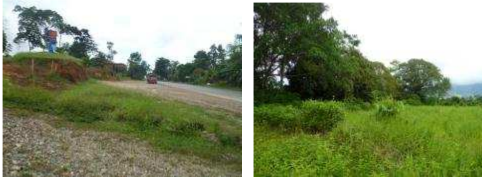
Fotografía 2-5 Zona de corte por atrás de la estación de gasolina Líbano
