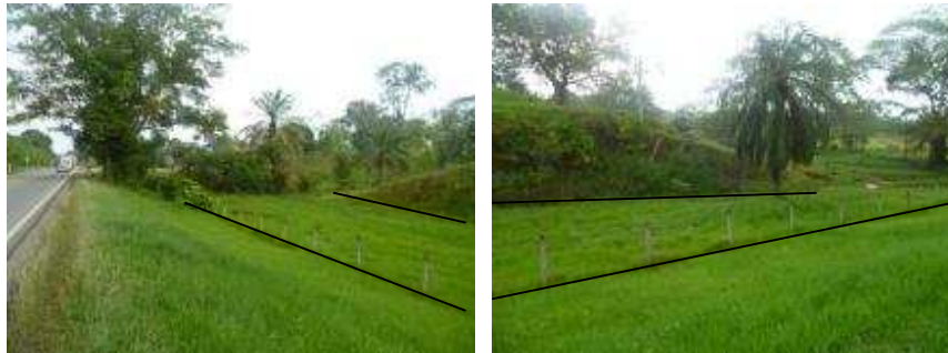
Fotografía 2-1 Franja de inundación por desborde de la corriente del PR6+910 al costado derecho de la vía existente
