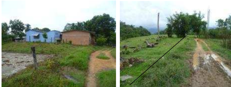
Fotografía 2-3 Localización de equipamiento e infraestructura sobre la terraza cerca del trazado de la variante
