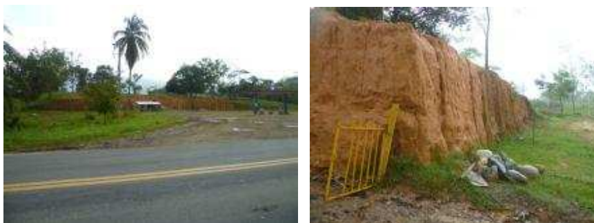
Fotografía 2-2 Terraza localizada por atrás de la estación de gasolina El Mirador de Líbano por donde pasa la variante
