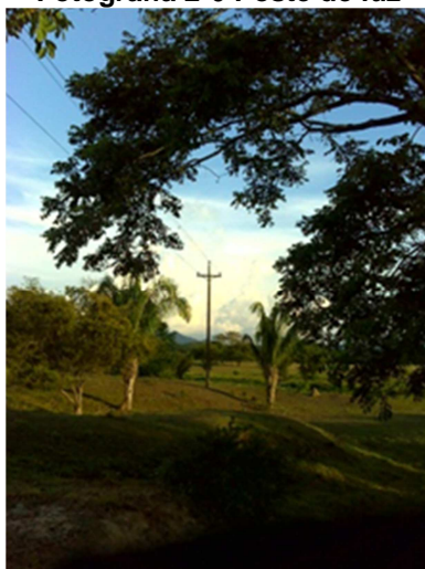
Fotografía 2-6 Poste de luz
