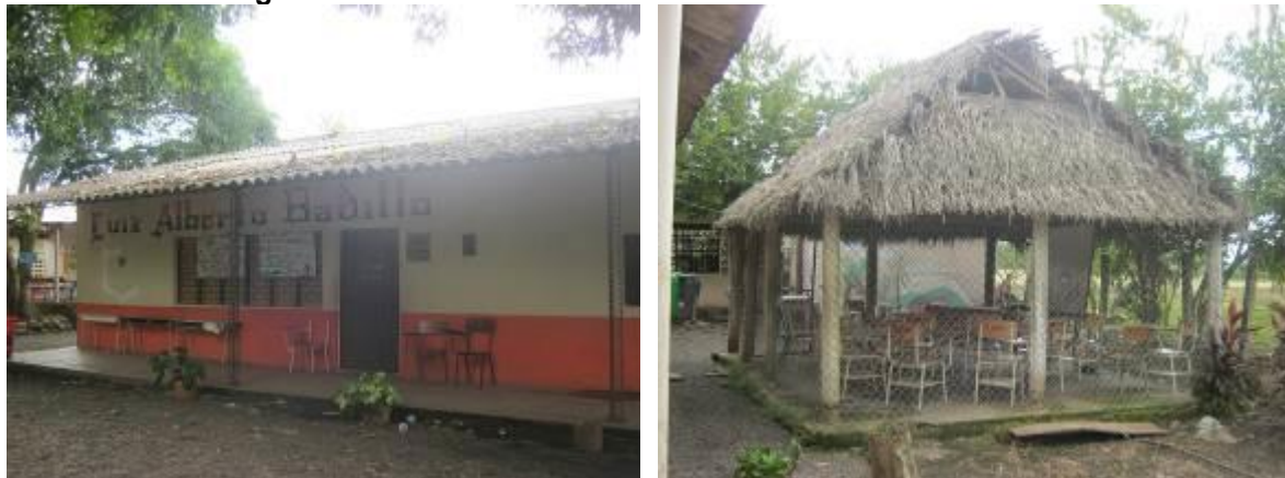
Fotografía 3-17 Instalaciones del centro educativo Luis Alberto Badilla
