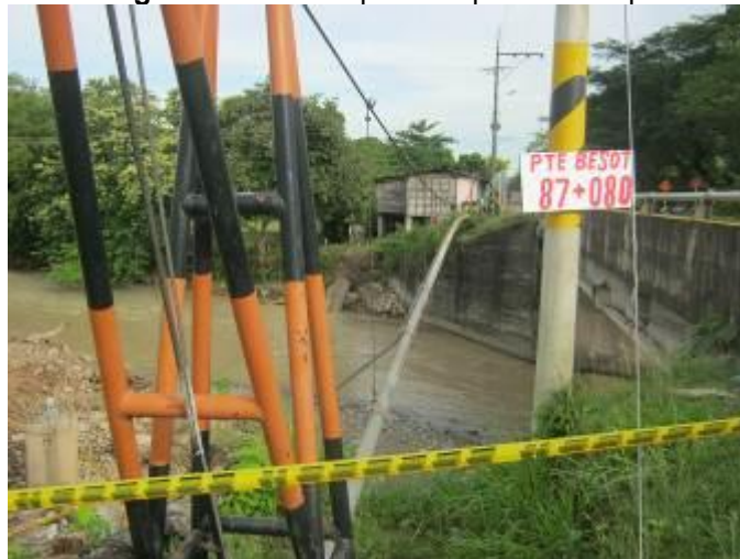
Fotografía 3-14 Red que transporta fibra óptica
