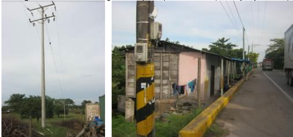
Fotografía 3-13 Red de energía interceptada por la variante (Media y baja tensión)
