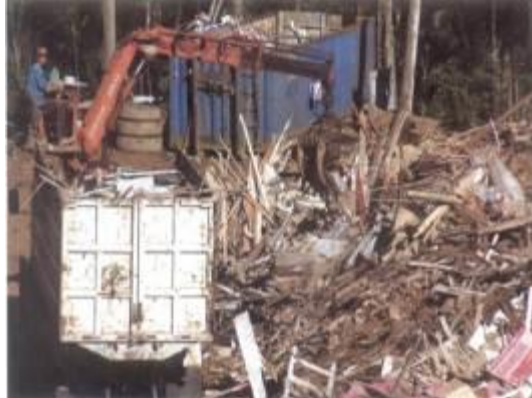
Figura 7-1 Disposición de residuos de construcción y demolición 1
