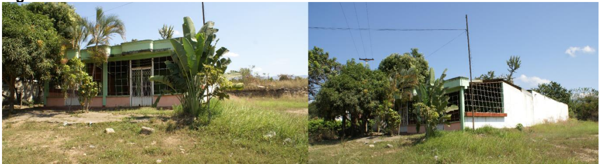
Fotografía 3-32 Construcción ubicada en la zona de intervención - Ubicada Cerro de los Chivos
