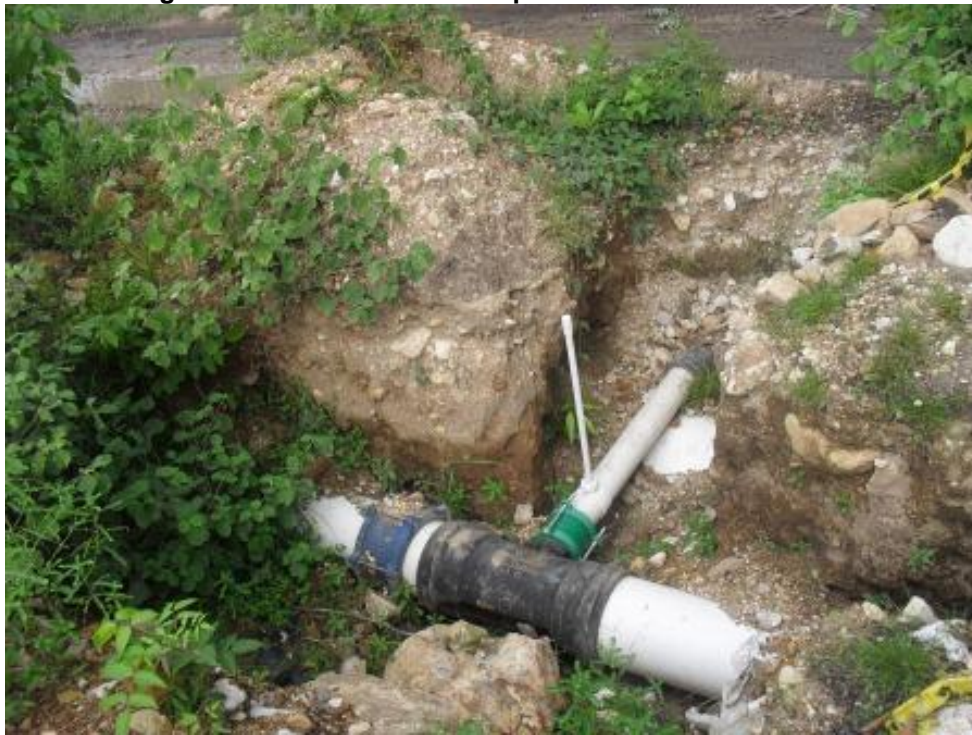
Fotografía 3-18 Paso de Tubería por la Zona de Intervención.
