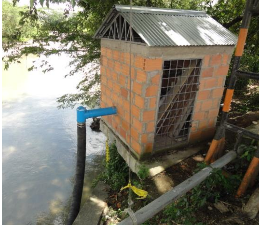
Figura 4-3 Captación río Carare
