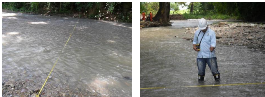
Figura 7-15 División transversal de la fuente y medición de profundidades
