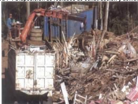
Figura 7-1 Disposición de residuos de construcción y demolición 1
