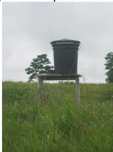
Fotografía 2-11 Tanque de almacenamiento
