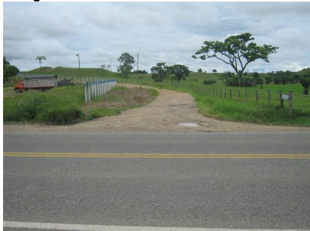
Fotografía 2-14 Acceso veredal en el PR 14+580
