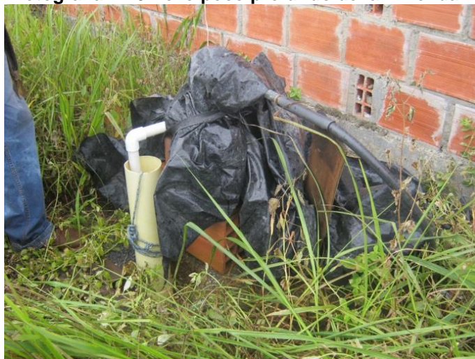
Fotografía 2-10 Pozo poco profundo de la vivienda
