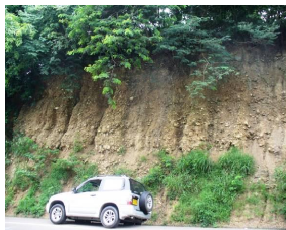
Fotografía 3-16 Taludes abanico aluvial, erosión en cárcavas, K55+750
