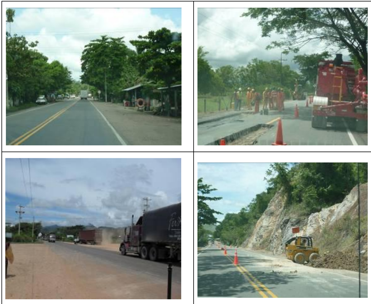
Fotografía 3-46 Estado de las vías y áreas aledañas en la zona de estudio
