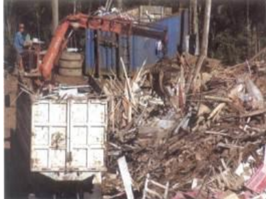
Figura 7-1 Disposición de residuos de construcción y demolición 1
