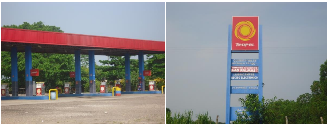
Fotografía 2-1 Estación de Servicio Las Palmas
