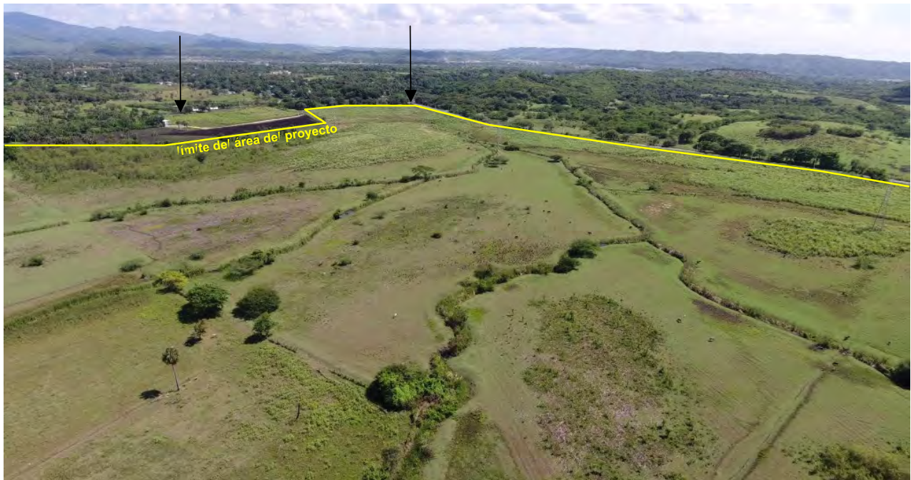
Figura 2.3.5-2. Tercio norte del área del proyecto, donde las vías de escurrimiento local se concentran y drenan.
