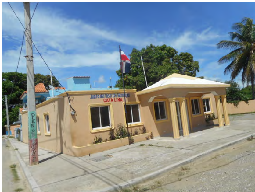
Foto 2.6.6.6-2. Edificio de la junta del distrito municipal Catalina (Empaca, 26-9-2019).
