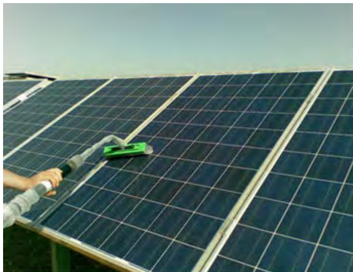
Foto 6.3.3-1. Forma de limpieza de los paneles solares.
