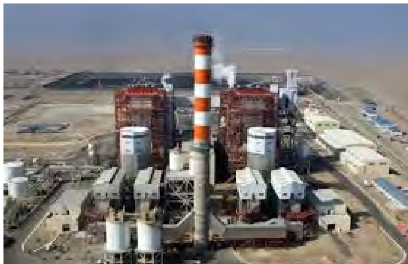
Foto 2.6.5-4. Vista de la planta generadora de electricidad Punta Catalina (tomada del internet).
