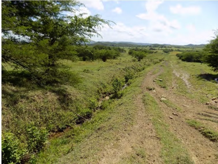
Fotos 2.3.5-3. Vías de escurrimiento superficial desde el Canal Marcos Cabral hacia la llanura.
