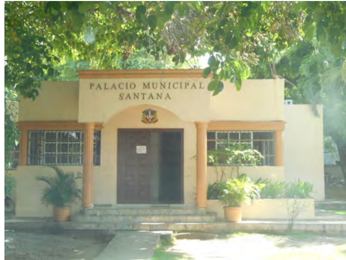
Foto 2.6.6.6-1. Edificio Ayuntamiento distrito municipal de Santana (tomada 26 septiembre de 2019).
