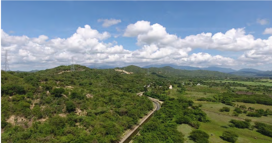
Foto 2.3.5-2. Distribución del canal Marcos Cabral al pie de la Loma La Majagua, que interrumpe todo el escurrimiento superficial desde la elevación hacia la llanura.
