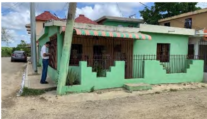
Foto 2.6.5.1-1.- Vivienda en Guerra. Foto tomada por EMPACA, 7 de septiembre 2021.
