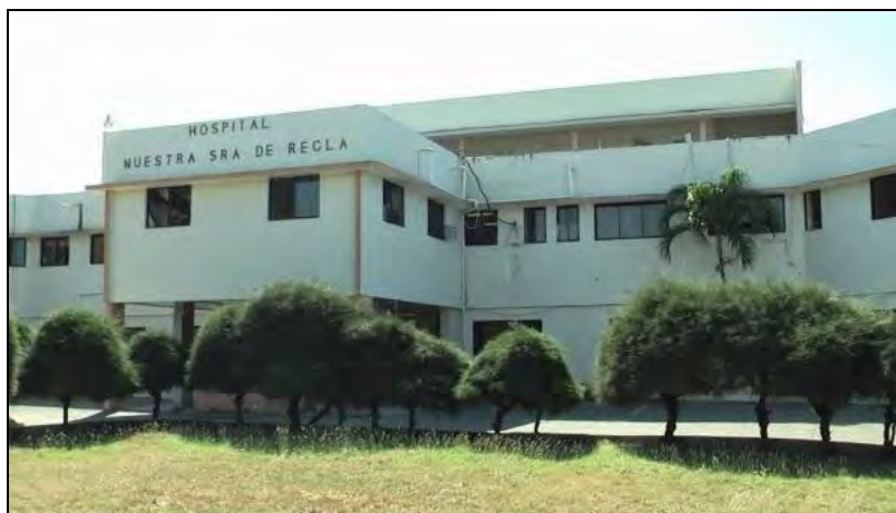
Foto 2.6.6.8-1. Hospital Nuestra Señora de Regla, ubicado en la zona urbana del municipio de Baní.
