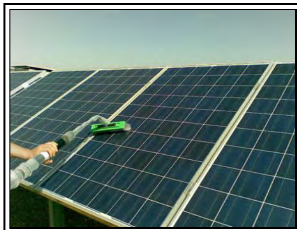
Foto 6.3.3-1. Forma de limpieza de los paneles solares.
