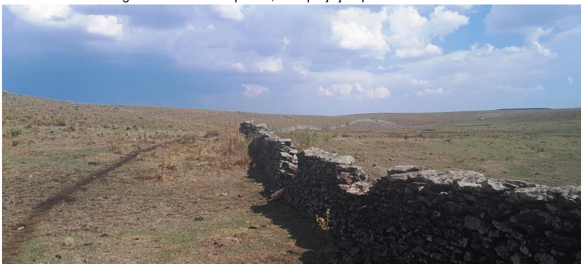
Figura 21: Setor colapsado, com projeção para a face interna.
