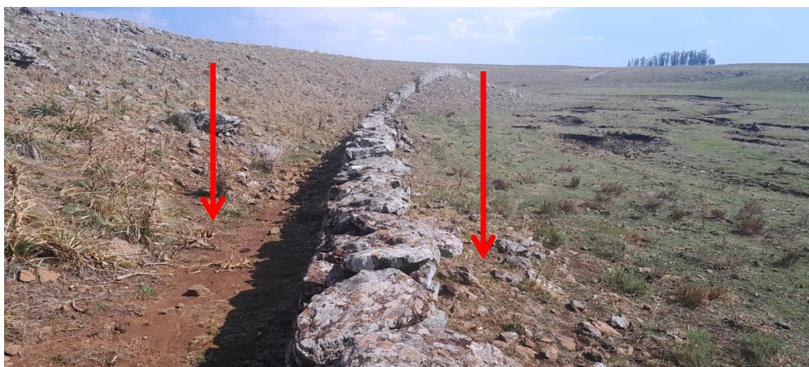
Figura 23: Diferenças de cotas. Mais alta na face externa, por acúmulo, e mais baixa na interna. Ação que pode originar inclinação e desmoronamentos pontuais.
