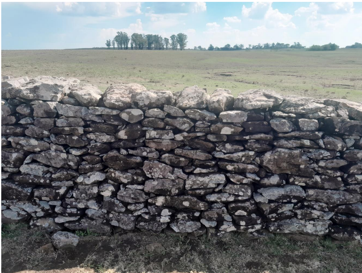
Figura 04: Técnica construtiva, onde se vê o travamento com cunhas de pequeno porte.
