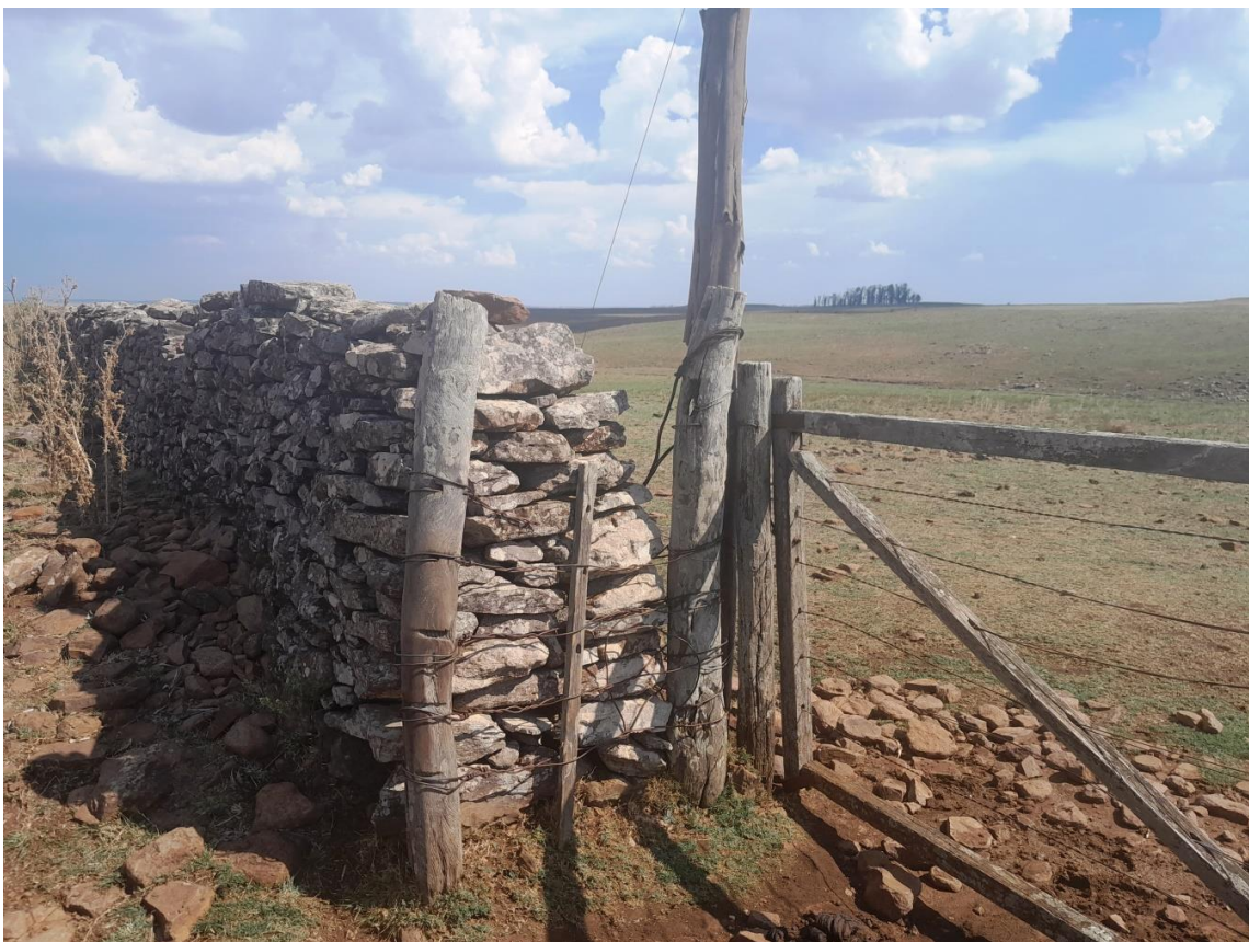
Figuras 06 e 07: Cunhais do muro. Vãos para manejo e acesso.
