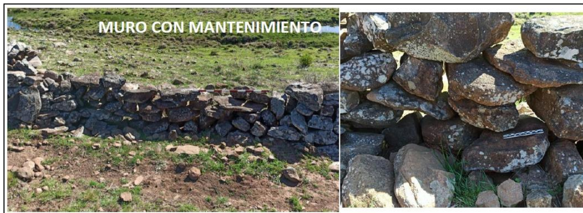
Figura 17: Registro de recomposição de estruturas no local. Acervo Joaquín Mazarino.
