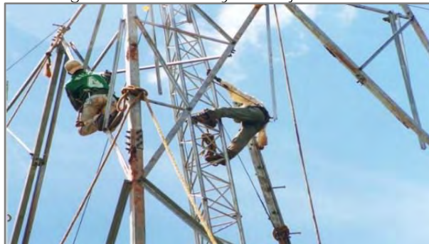
Figura 40 Ensamble y montaje de torres
