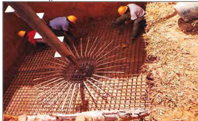
Figura 39 Cimentación de torres.
