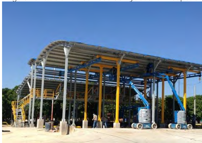
Figura 25 Estación de bombeo de Ayacucho - Ecopetrol
