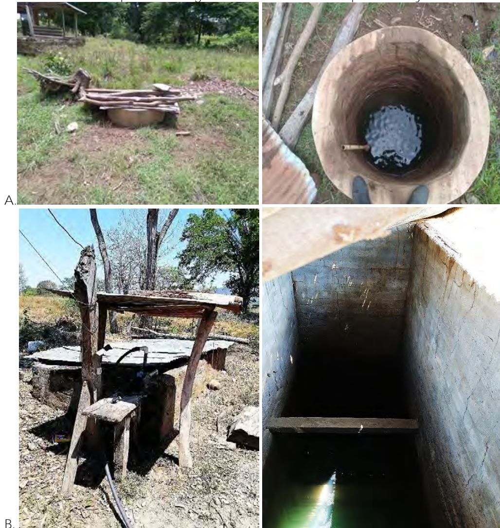
Figura 29 Sistemas de Captación de Aguas Subterráneas. A. Pozo profundo 1 y B. Pozo Profundo 2
