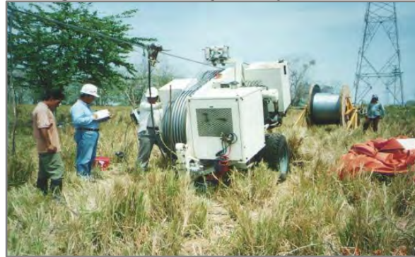
Figura 41 Ensamble y montaje de cables
