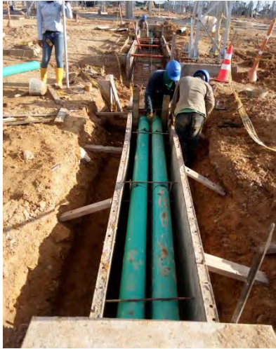
Figura 6. Construcción de banco de ductos para línea subterránea de alta tensión
