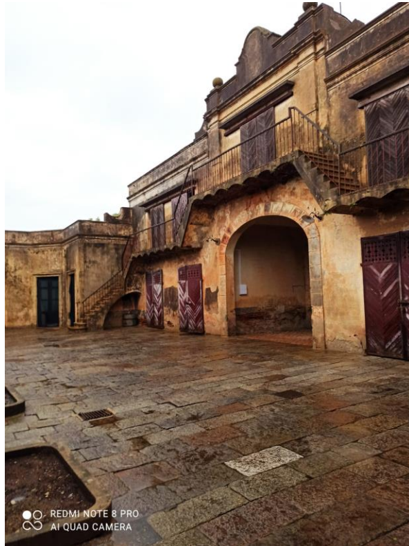
Figura 12: Vista de um dos pátios internos. Detalhe da arquitetura característico do início do século XX.
