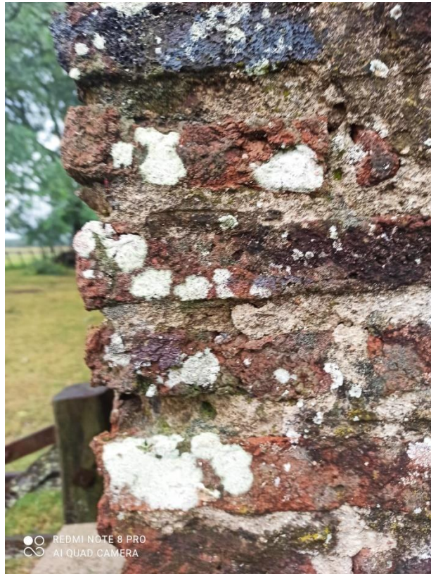
Figura 21: Detalhe da parede de tijolos maciços da construção ao lado do galpão, a qual aparentemente foi em parte restaurada.
