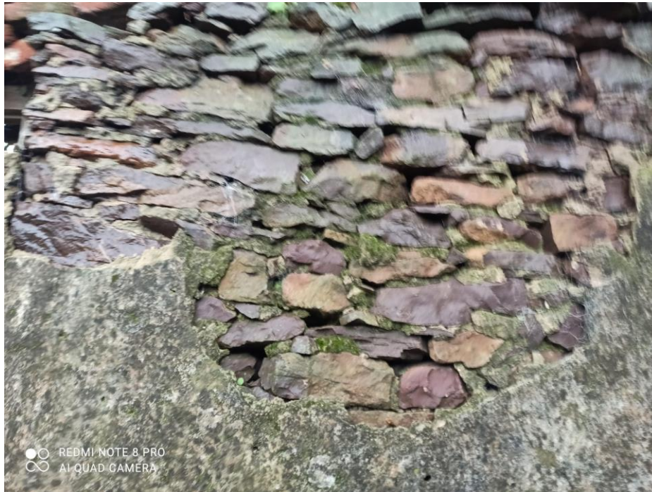
Figura 23: Detalhe da parede de pedra da construção com reboco, demonstrando o restauro desta.
