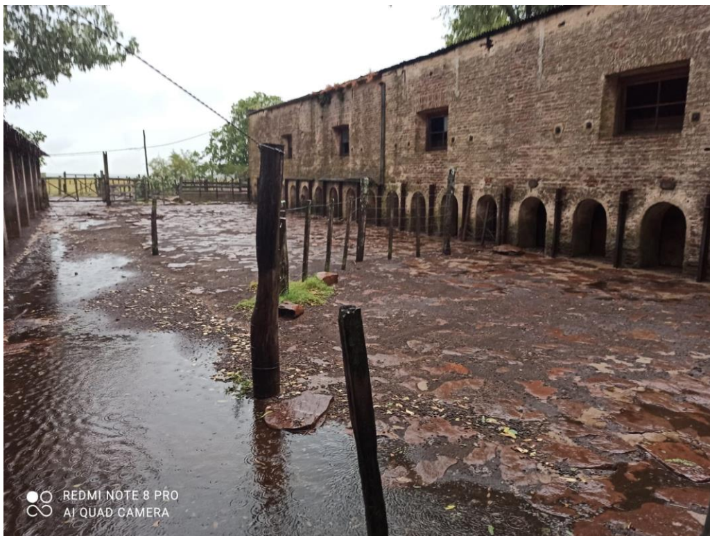
Figura 22: Vista da estrutura pecuária atrás do galpão. Detalhe para a relação do piso de rocha e as paredes de tijolo maciço.
