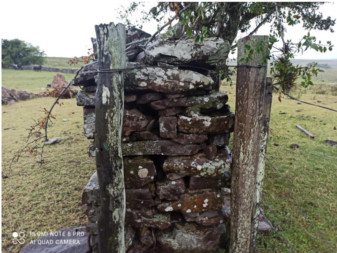
Figura 24: Vista em detalhe da forma construtiva da taipa de pedra do curral redondo.
