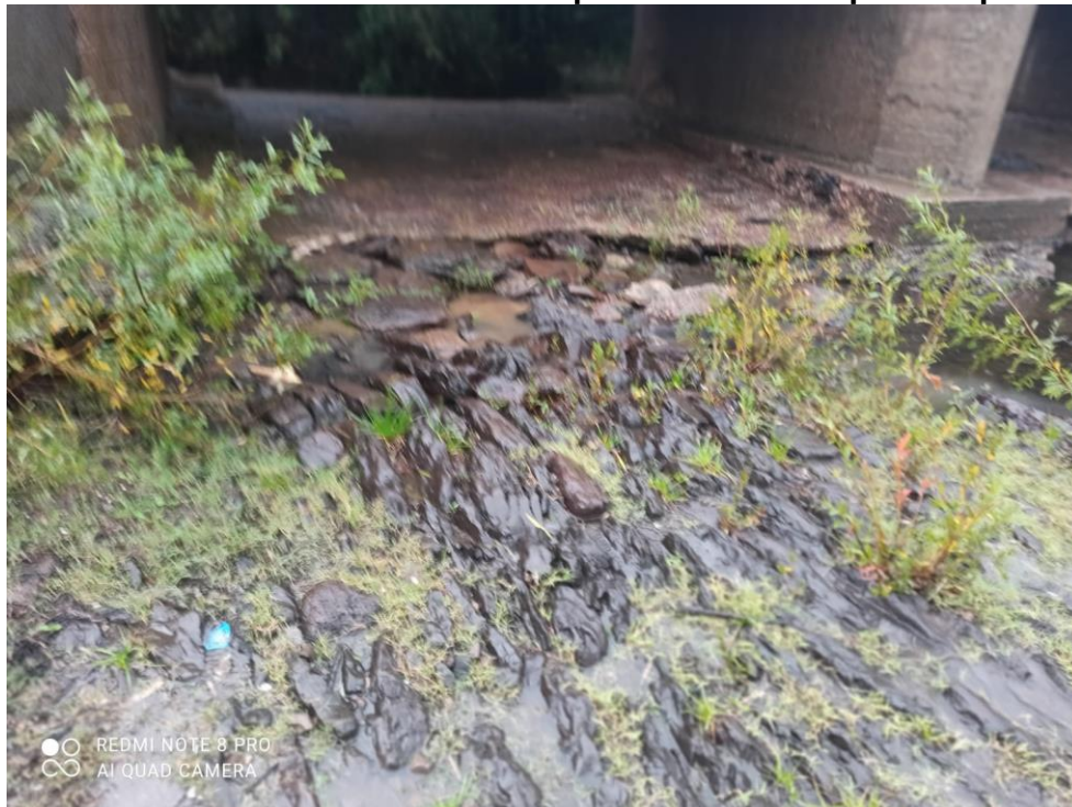
Figura 18: Detalhe da base de pedra utilizada para a travessia no passado.
