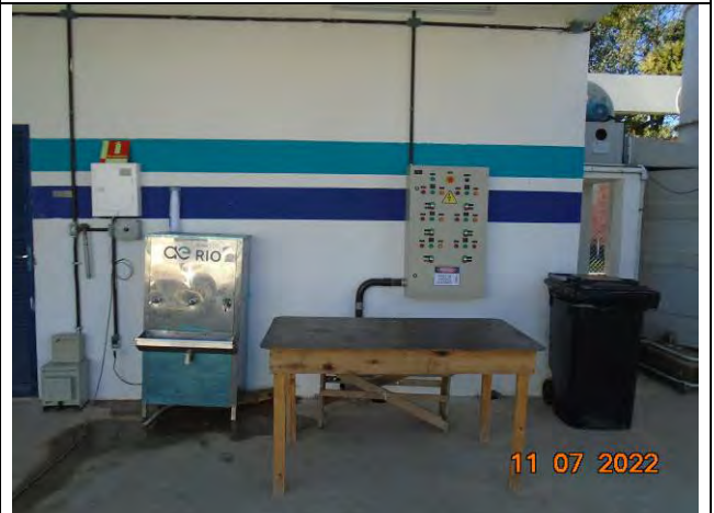
Foto 34: Área de convivência utilizada pela equipe de manutenção/obras.
