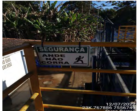
Foto 16: Registro de sinalizações de segurança na ETA.
