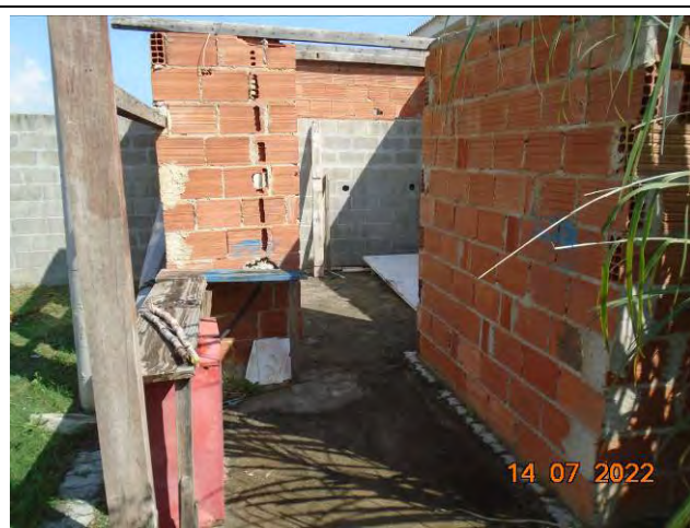
Foto 24: Vista geral de instalação desativada na ERES Taça.
