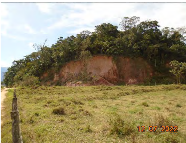
Foto 21: Margem direita do Rio Guapiaçu. Detalhe de processo erosivo.
