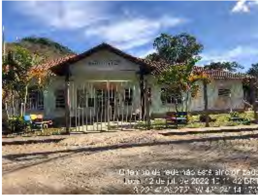
Foto 021: Vista da fachada da creche municipal ao lado da estação de tratamento
