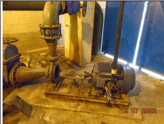
Foto 13: Estado de conservação de equipamentos.
