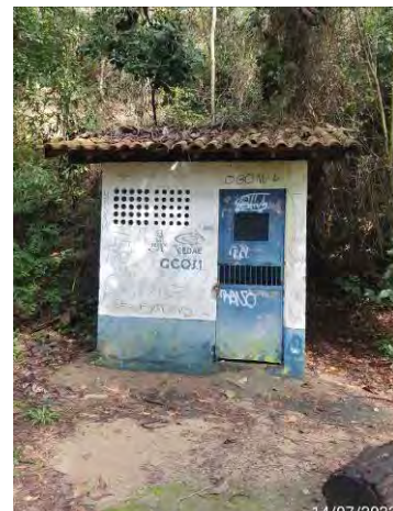
Foto 32: Registro da área de armazenamento dos produtos químicos.
