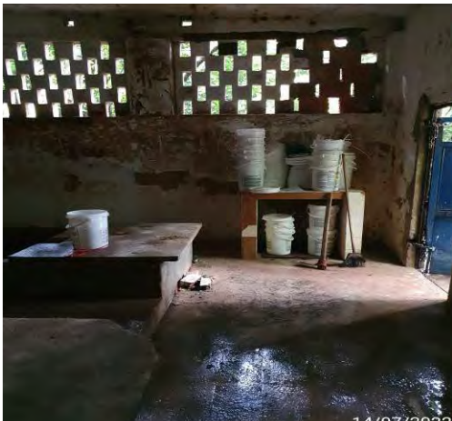
Foto 43: Recipientes de produtos químicos dispostos de forma irregular.
