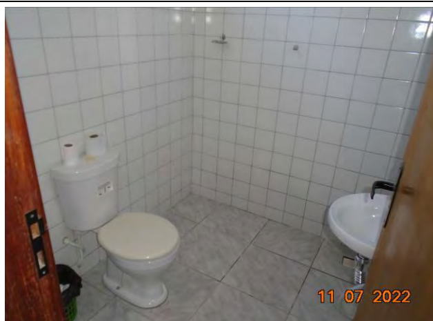
Foto 17: Detalhe do sanitário 1 da área administrativa.
