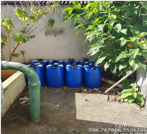
Foto 15: Vista dos produtos químicos dispostos de forma irregular, sem bacia de contenção, sem sinalização e sem extintor na área.
