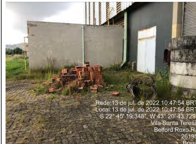
Foto 07: Registro de resíduos dispostos de forma irregular.
