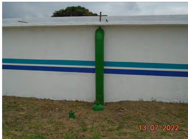
Foto 09: Reservatório de água.
