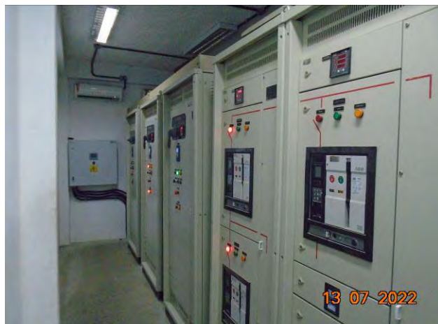
Foto 11: Área interna da sala de painéis.
