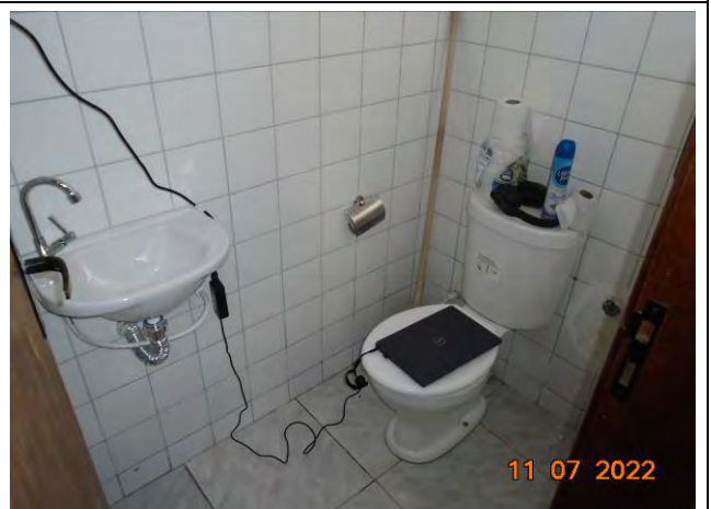
Foto 18: Detalhe do sanitário 2 da área administrativa.
