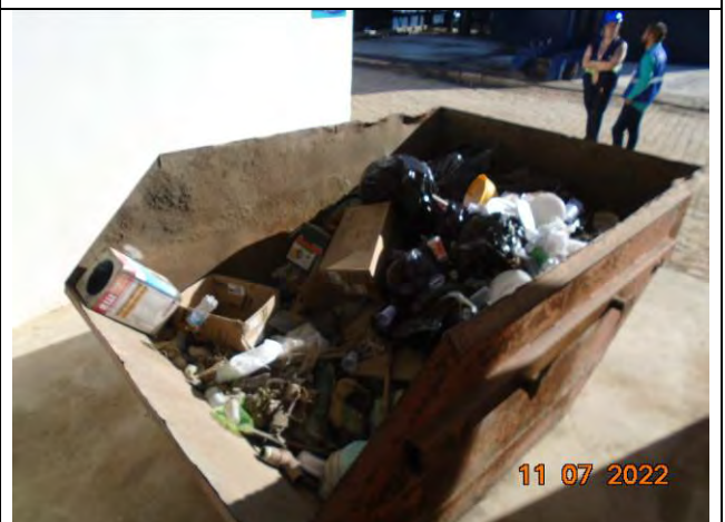
Foto 36: Disposição inadequada de resíduos na caçamba (latas de tinta, EPIs, resíduos comuns e etc.).
