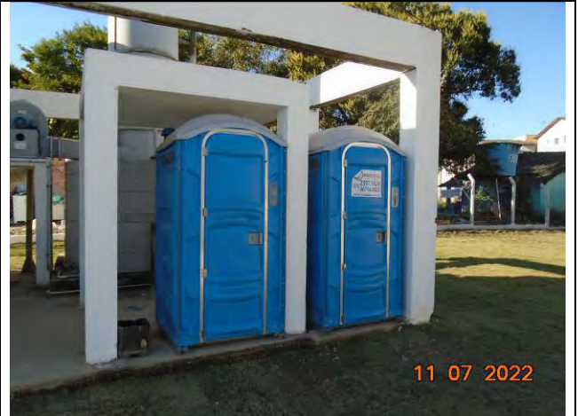
Foto 32: Sanitários químicos da equipe de manutenção/obras.
