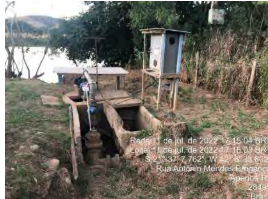
Foto 04: Bomba utilizada na unidade EAAB Rio Pomba.
