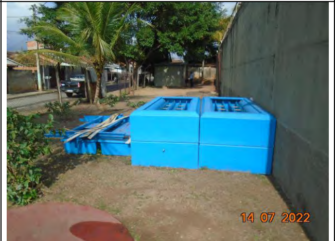
Foto 34: Material do aerador desativado exposto à intempéries.
