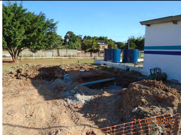
Foto 31: Área externa em manutenção.
