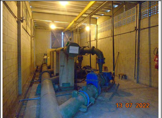
Foto 10: Casa de bombas - visão geral.
