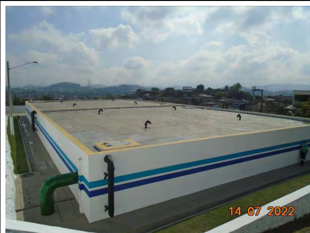
Foto 06: Vista geral da parte superior do reservatório.
