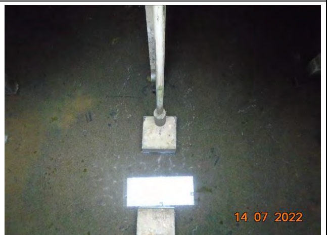
Foto 18: Caixa de aerador (sistema de batelada).
