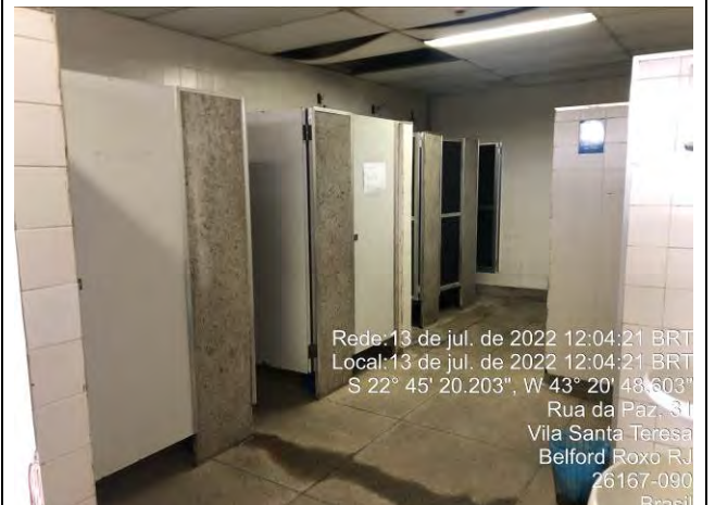
Foto 14: Registro do sanitário dos operadores.
