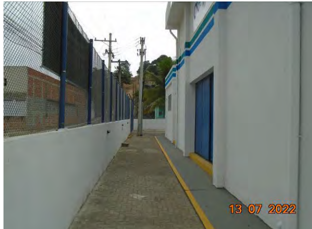
Foto 13: Área externa lateral indicando bom estado de conservação da unidade.
