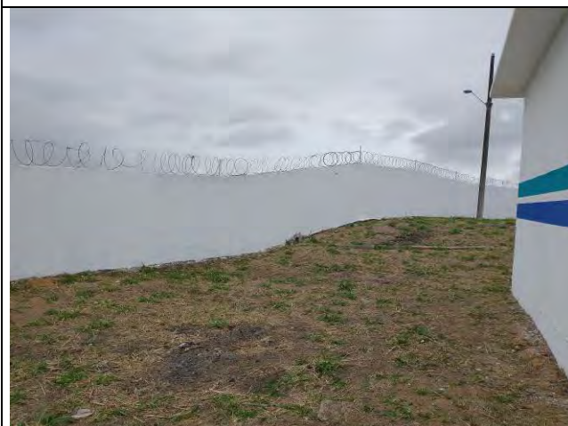
Foto 47: Parte superior do terreno, na lateral do reservatório de água.
