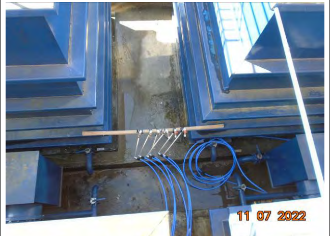
Foto 04: Exemplo de vazamentos (piso molhado) identificados no processo de tratamento e detalhe das mangueiras de conexão entre os tanques e a tomada de água para as amostras ambientais.
