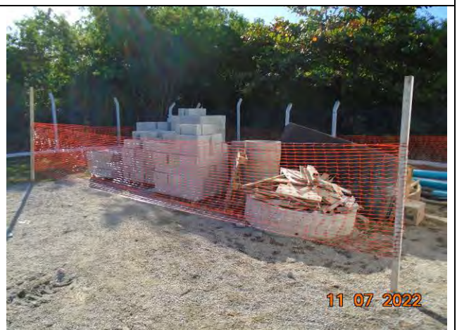
Foto 30: Armazenamento dos materiais de construção utilizados na reforma da Unidade.
