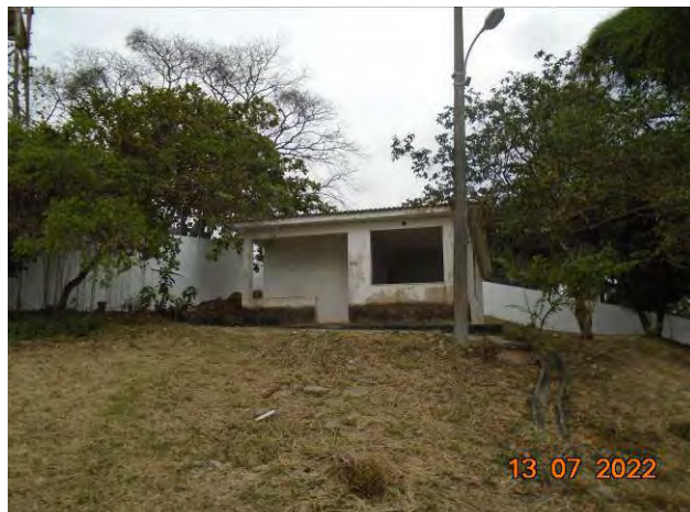
Foto 15: Casa abandonada utilizada na época da CEDAE.
