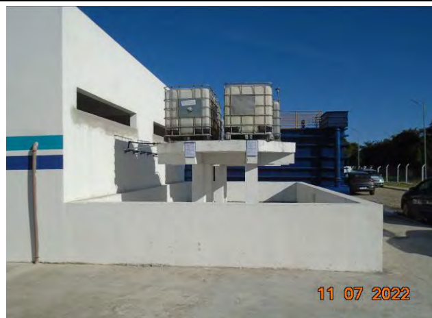
Foto 10: Tanques de sulfato de alumínio ferroso que estão conectados ao sistema de tratamento para gotejamento automático (outro ângulo).
