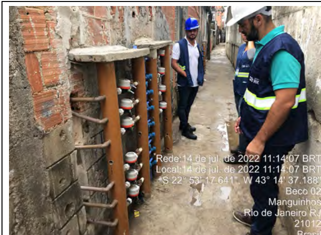
Foto 01: Registro do momento da visita na comunidade do Arará, de dispositivos de hidrômetros para medição de consumo de água da população.
