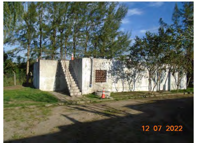
Foto 10: Vista geral do sistema de tratamento por batelada.
