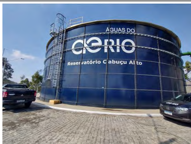
Foto 01: Detalhe da identificação do ERES Cabuçu Alto.
