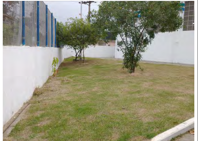
Foto 14: Área externa lateral indicando bom estado de conservação da unidade – outro ângulo.
