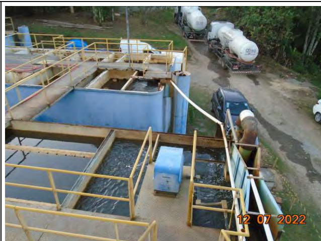
Foto 20: Detalhe da entrada da água bruta na ETA Caceribú.
