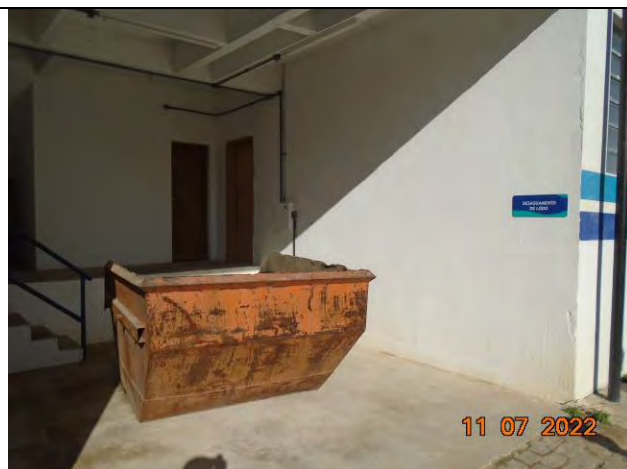
Foto 35: Caçamba de entulho em uso para a equipe de manutenção/obras.
