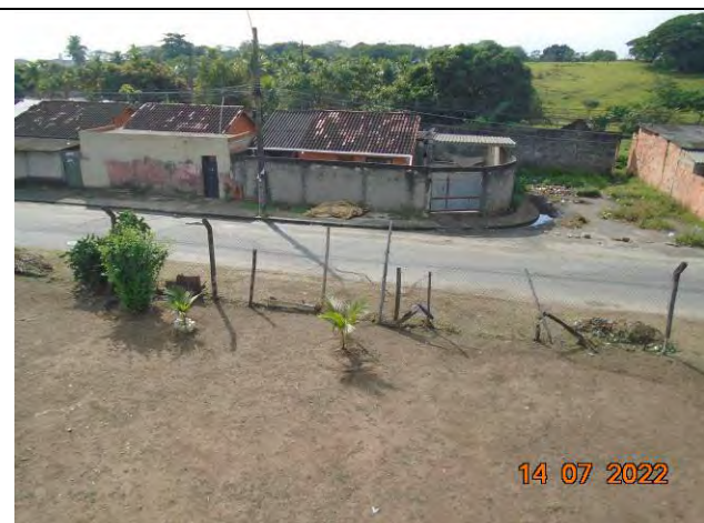
Foto 29: Cercamento deteriorado da área da Unidade.
