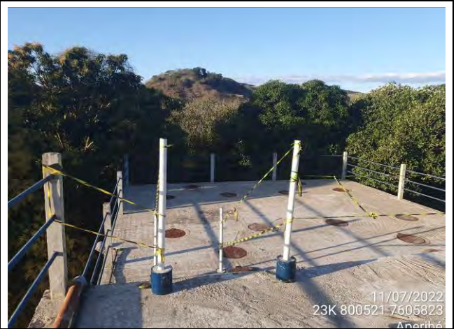
Foto 08: Vista do sistema da ETE sem guarda-corpo.
