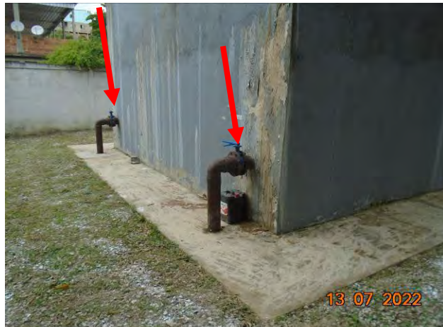
Foto 03: Bombeamento do efluente bruto após passagem pelo gradeamento.
