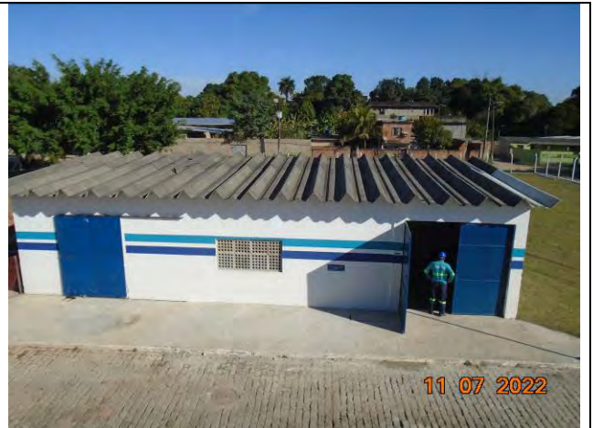
Foto 26: Elevatória de água tratada.
