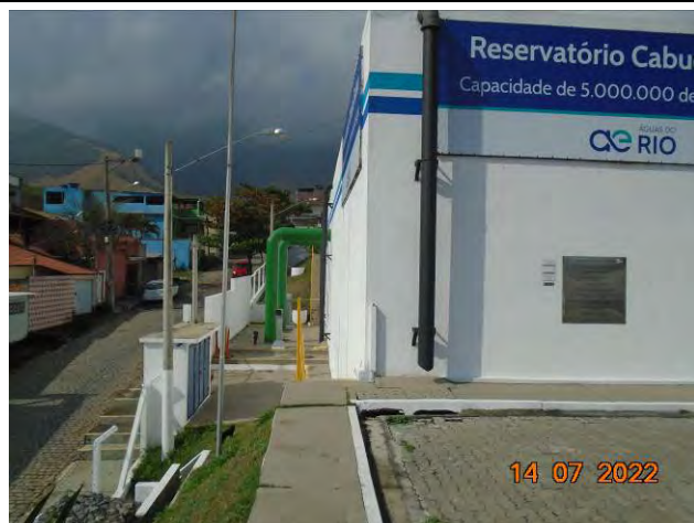
Foto 03: Vista geral da lateral do reservatório.
