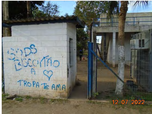
Foto 01: Vista geral da entrada da ETE Grande Rio I.
