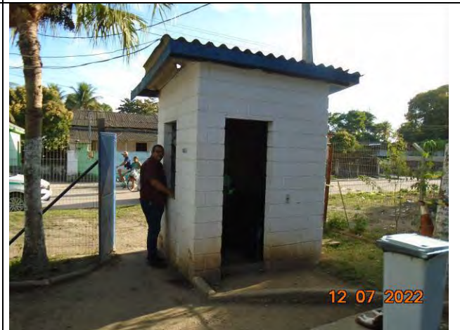
Foto 16: Vista geral da guarita.
