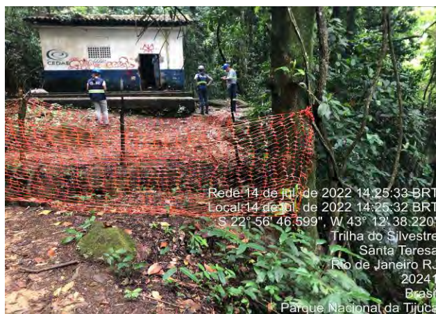
Foto 33: Registro da UT Paineiras.
