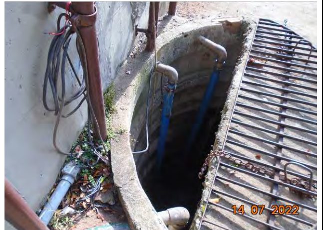
Foto 14: Detalhe da caixa que ficam as bombas que elevam o material bruto para a área superior da unidade.
