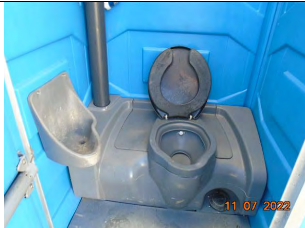
Foto 33: Detalhes de conservação do sanitário utilizado pela equipe de manutenção/obras.
