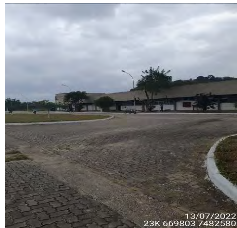
Foto 04: Vista geral do prédio administrativo.
