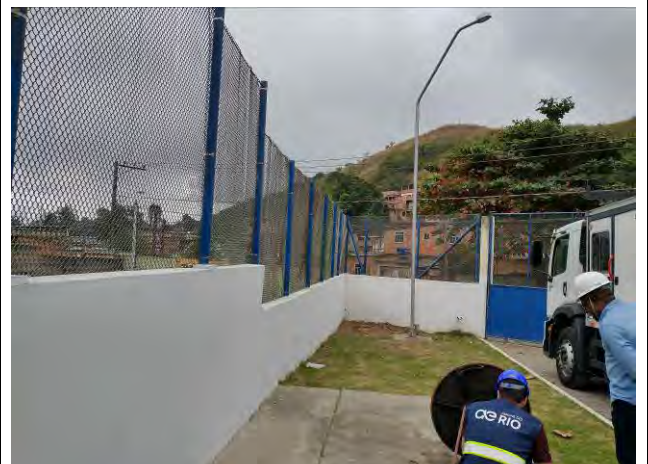
Foto 12: Área externa em atividade de manutenção.
