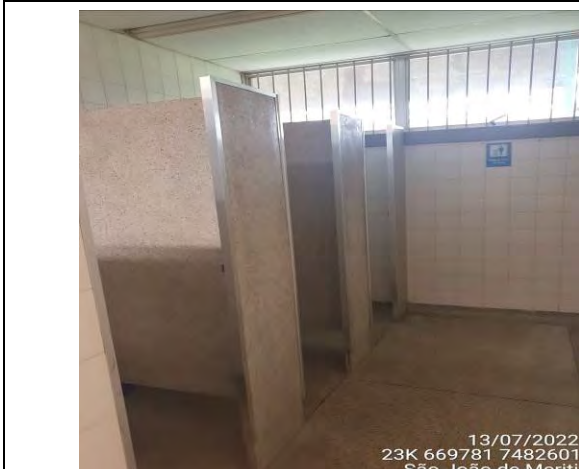
Foto 05: Registro do banheiro.
