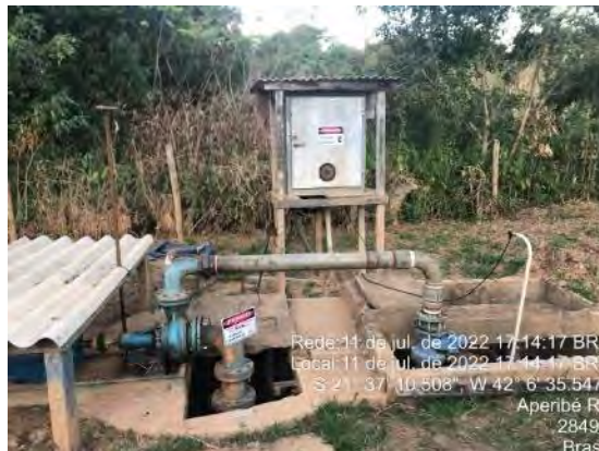
Foto 06: Registro detalhado da bomba na Estação Elevatória de Água Bruta Rio Pomba.
