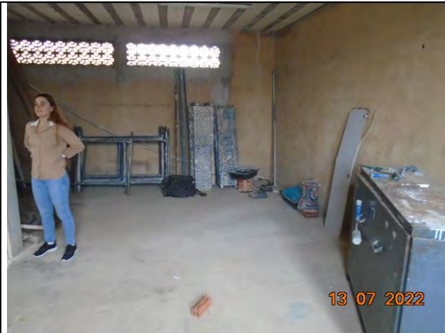
Foto 37: Uma das salas da área administrativa que está em desuso.
