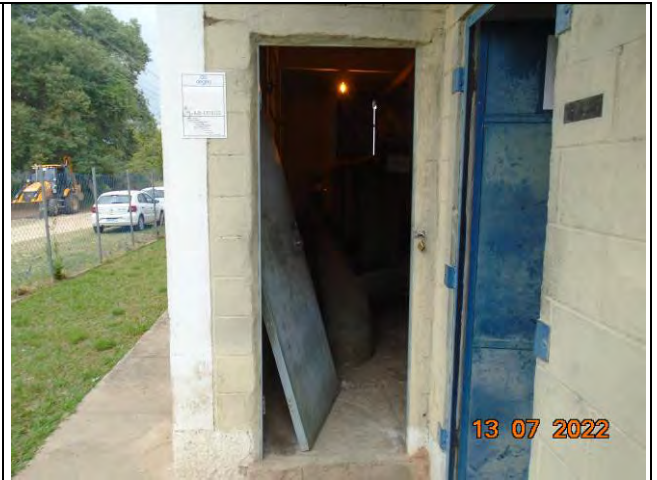
Foto 14: Porta de acesso à casa de bombas. A porta foi recolocada após visitaçao.
