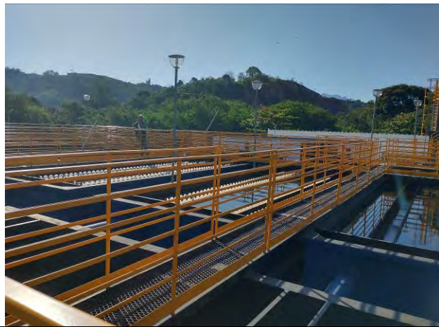
Foto 01: Vista geral dos conjuntos de tratamento da ETA Magé.
