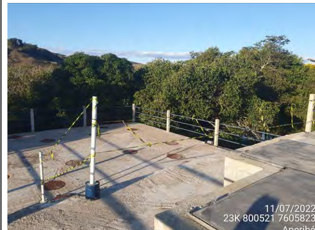
Foto 09: Vista do sistema da ETE sem guarda-corpo.
