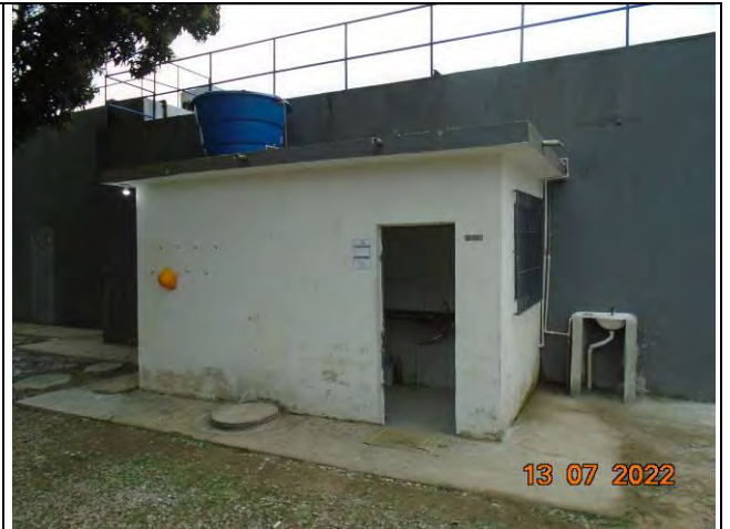
Foto 14: Prédio administrativo da ETE.
