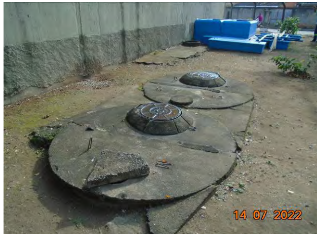
Foto 15: Caixas de areia.
