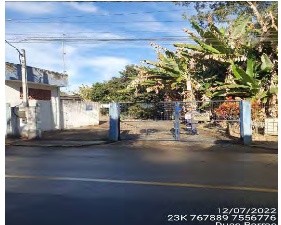
Foto 12: Vista geral da entrada da ETA Rio Macuco.
