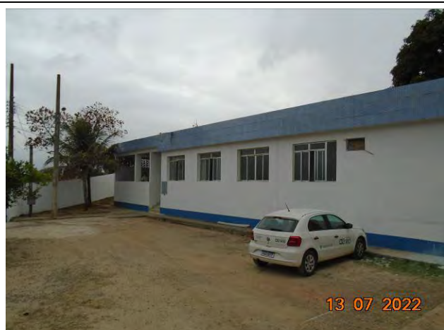
Foto 01: Visão geral da unidade.
