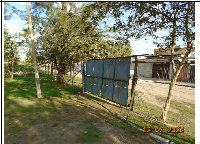
Foto 18: Detalhe de um dos portões. Salienta-se que o mesmo se encontra danificado.
