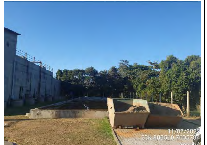
Foto 04: Detalhe das caçambas que armazenam a areia retirada do processo para destinação.
