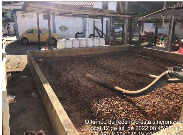
Foto 01: Vista geral da área de secagem do lodo.
