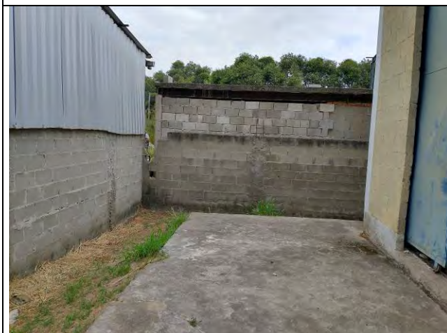
Foto 23: Área externa – fundos da sala de bombas.
