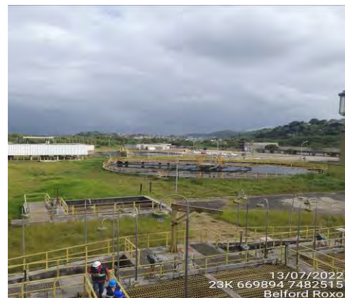
Foto 04: Vista geral dos decantadores da ETE.
