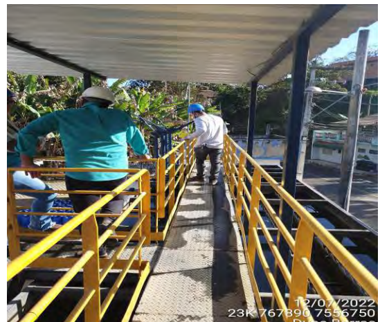
Foto 18: Vista da área do tratamento na ETA.
