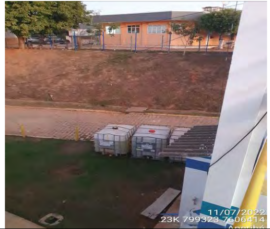
Foto 10: Vista dos produtos químicos dispostos de forma irregular, sem contenção ou extintor na área.
