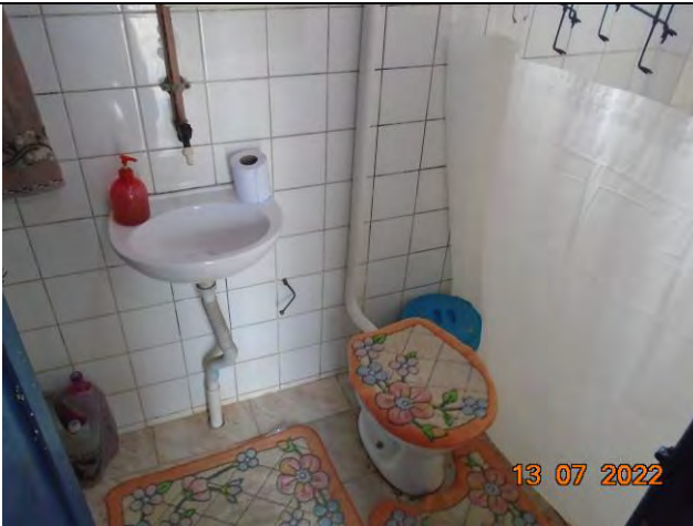
Foto 09: Banheiro localizado na área administrativa.
