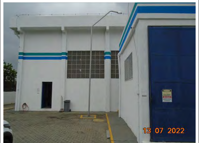
Foto 02: Pátio de acesso ao conjunto de bombas.
