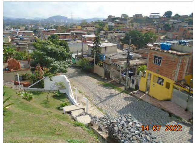
Foto 26: Detalhe da comunidade do entorno da EEAT Cabuçu Baixo.
