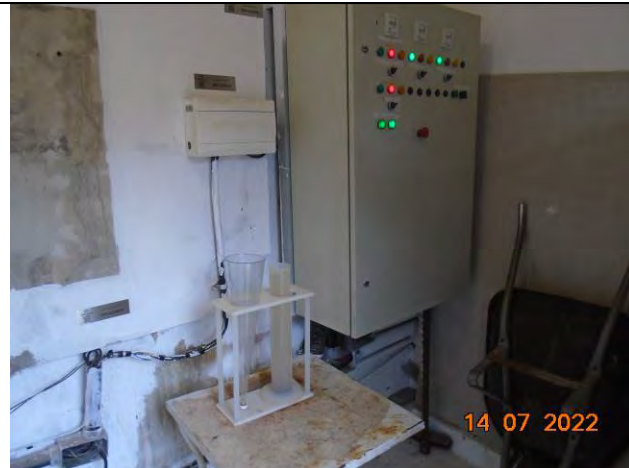
Foto 21: Área destinada às análises de qualidade do efluente.
