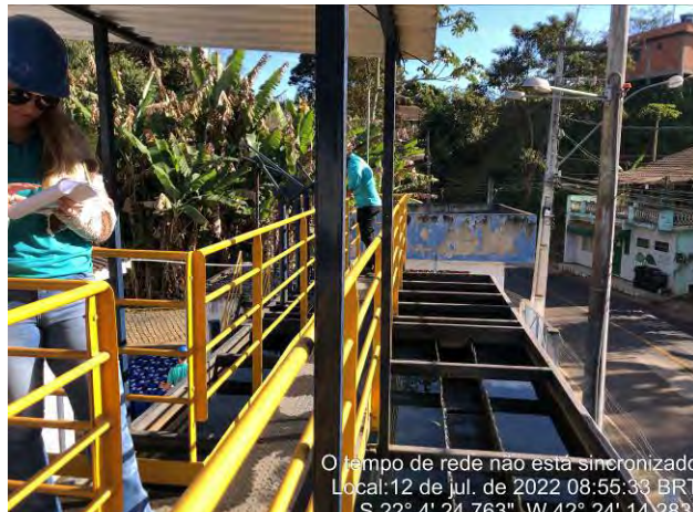
Foto 03: Vista geral da Estação de Tratamento Água Rio Macuco. Nota-se a falta de sinalização.
