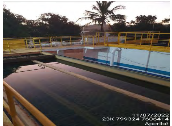
Foto 08: Vista da área de tratamento da ETA Aperibé.
