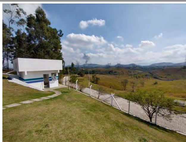
Foto 02: Vista geral da guarita devidamente identificada.
