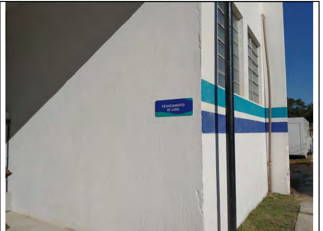
Foto 32: Instalação sendo finalizada para receber o desaguamento de lodo residual do tratamento de água.
