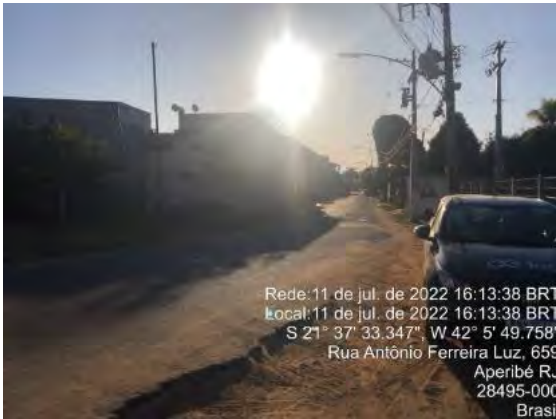
Foto 15: Vista geral da área do entorno da ETE Aperibé
