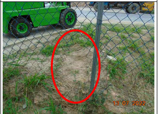
Foto 22: Área externa com cercamento danificado.
