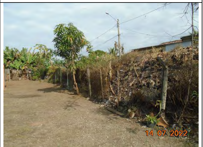
Foto 30: Cercamento deteriorado da área da Unidade.
