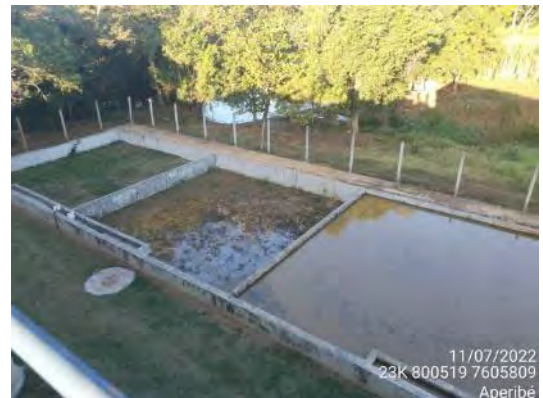
Foto 18: Vista geral da lateral da unidade com o Rio Pomba
