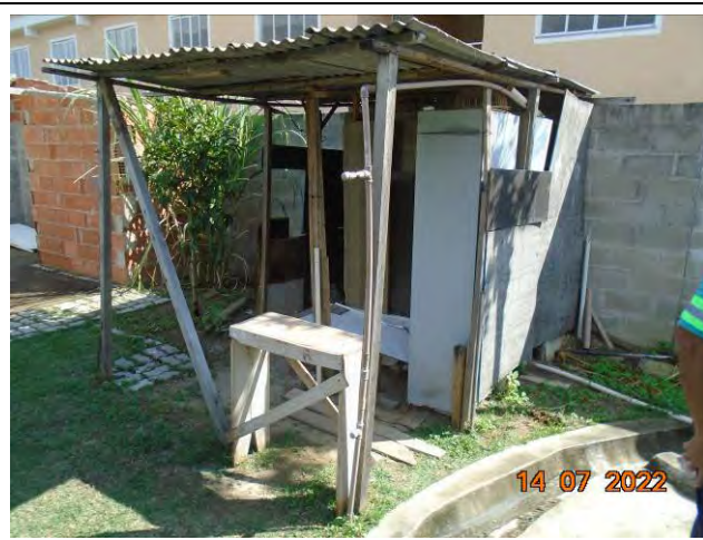
Foto 20: Vista geral do sanitário locado na ERES Taça. Detalhe das paredes de compensado (madeira).
