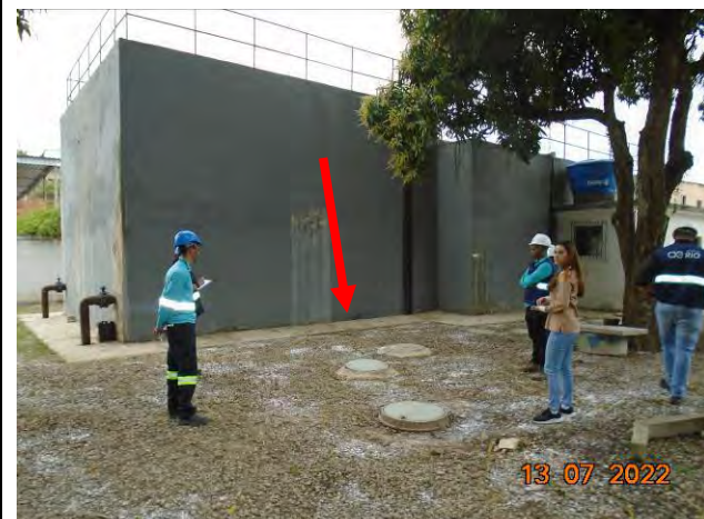
Foto 01: Caixas do sistema de gradeamento da ETE – entrada do sistema.
