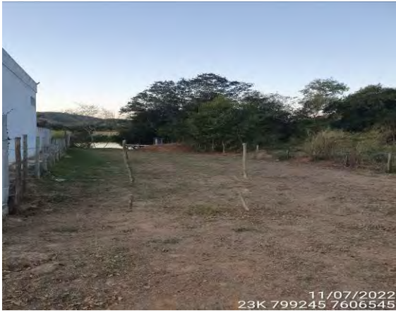
Foto 07: Vista geral da entrada da EEAB.
