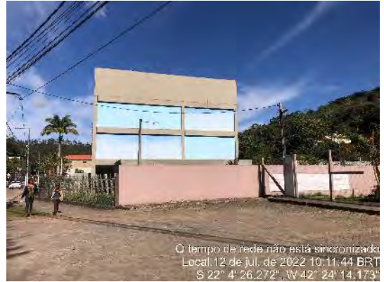
Foto 022: Visão lateral da escola CIEP próximo a ETA e vizinha da creche municipal.
