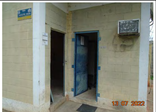
Foto 06: Vista geral da estrutura predial – porta da esquerda sala de bombas, porta da direita área administrativa.
