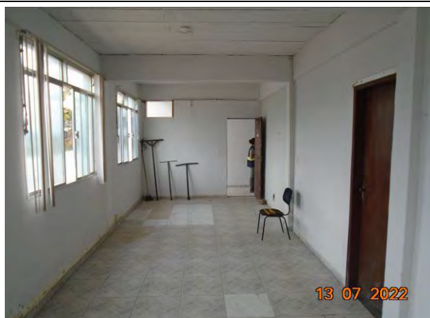
Foto 23: Sala administrativa em desuso.
