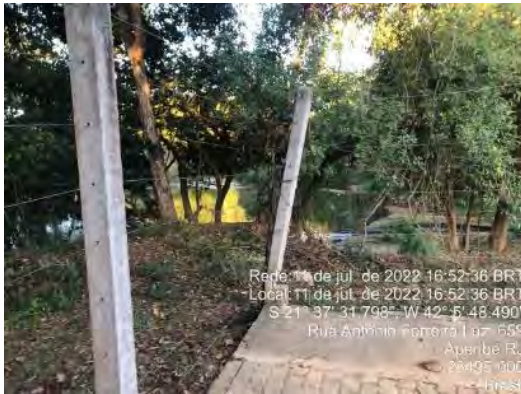
Foto 03: Fundo da ETE com o Rio Pomba.
