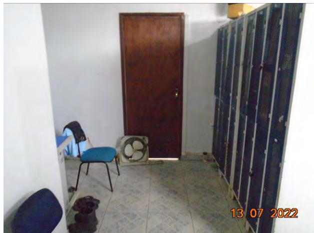
Foto 21: Vestiário na área administrativa.
