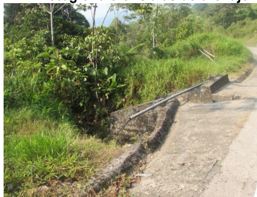
Fotografía 3-5. Obras de drenaje
