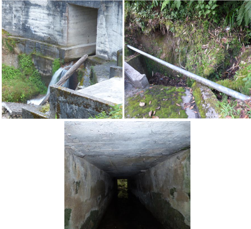
Figura 6.1. Obras de Drenaje actuales.
