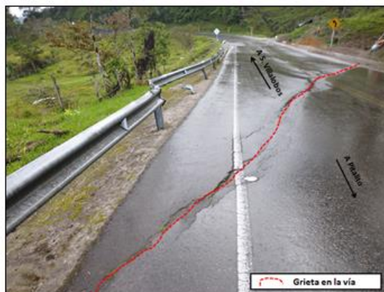
Figura 4. 19 Sentido del Movimiento Sitio Inestable 13 PR88+800
