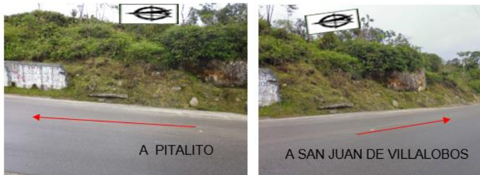
Figura 4. 14 Coluvión inestable- Sitio inestable UF5-SI04 (K75+000)
