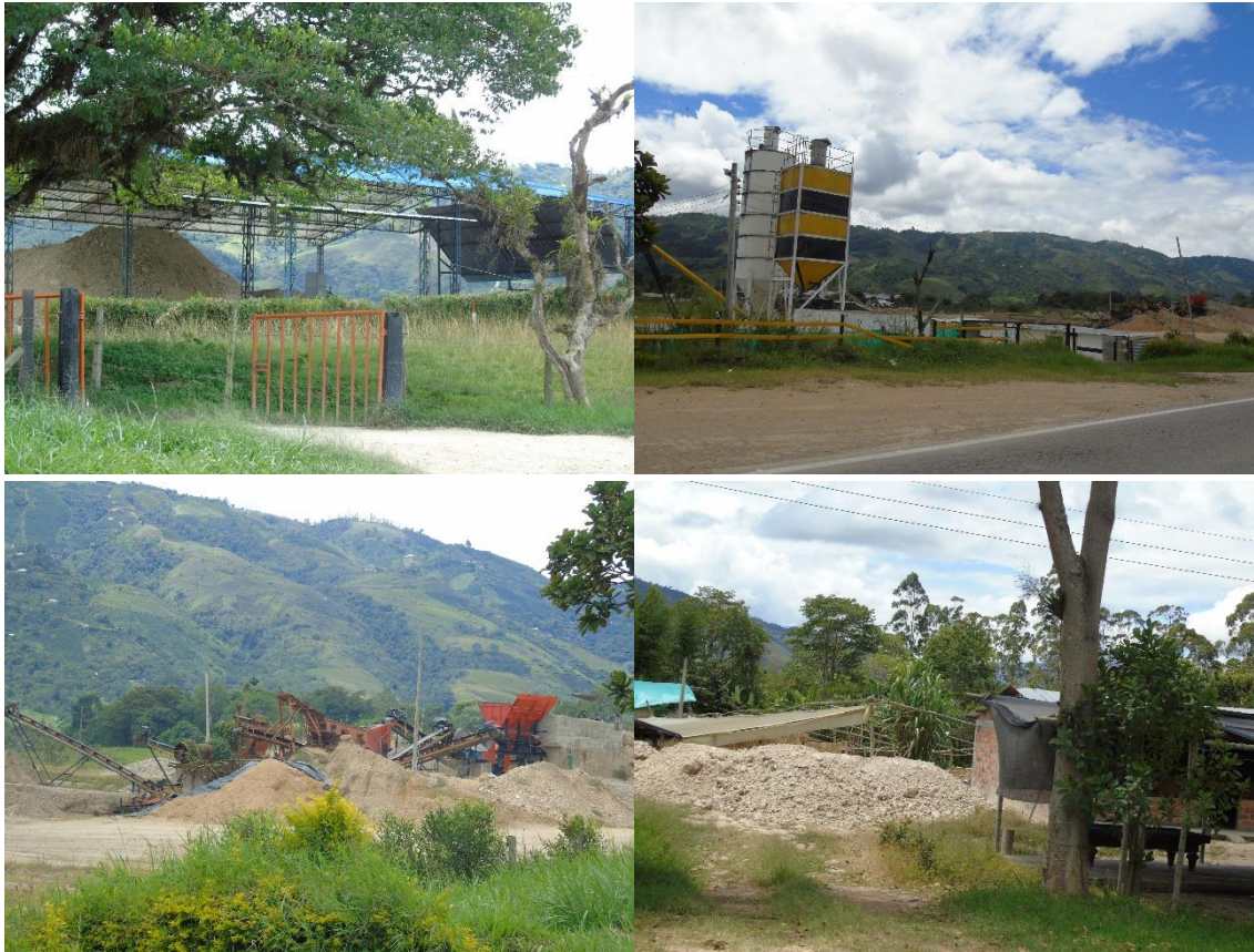
Figura 5.40A. Zonas de almacenamiento de material adyacentes a la vía actual
