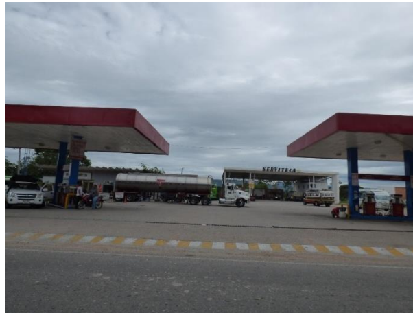
Figura 5.40C Estación de servicio UF4
