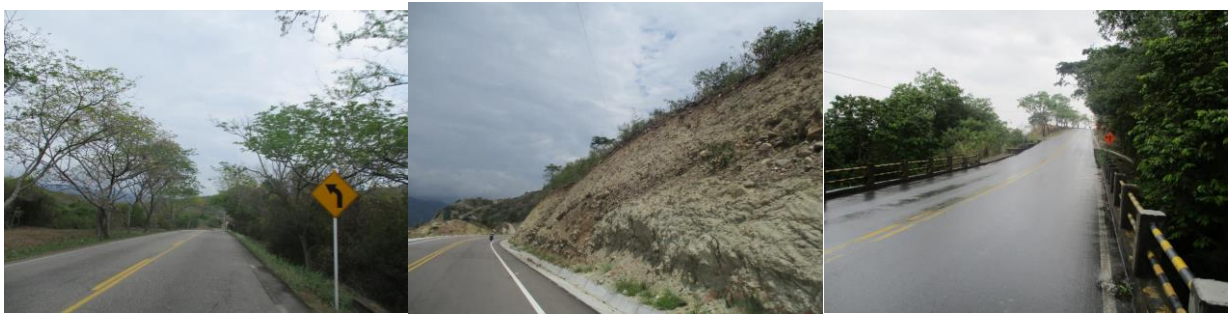
Fuente: Concesionaria Aliadas para el Progreso S.A.S. - G&R Ingeniería y Desarrollo S.A.S., 2016
