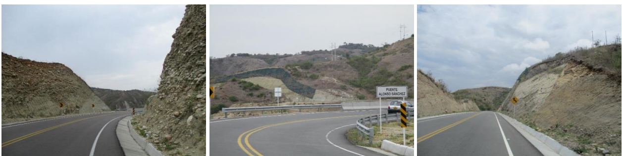
Fuente: Concesionaria Aliadas para el Progreso S.A.S. - G&R Ingeniería y Desarrollo S.A.S., 2016.
