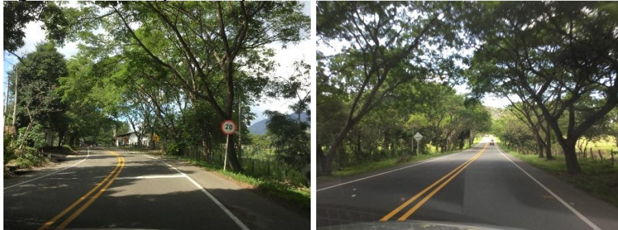
Figura 7-2 Accesos, predios o presencia de infraestructura en el derecho de vía
