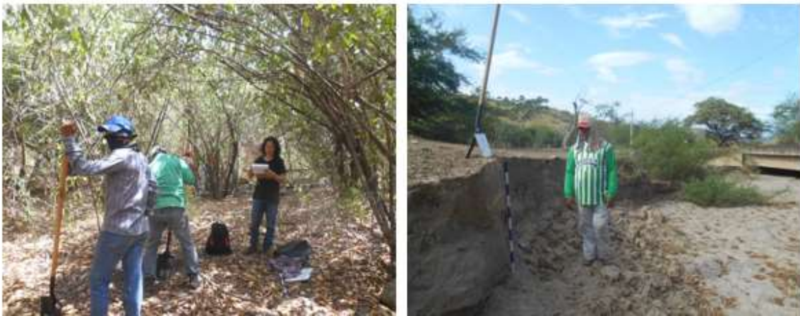
Figura 5-142 Realización de pozos de sondeo y perfiles estratigráficos en la UF2 Vía Nueva
