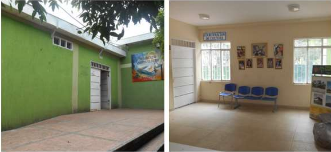
Figura 5-146 Instalaciones Biblioteca municipal y coordinación de cultura
