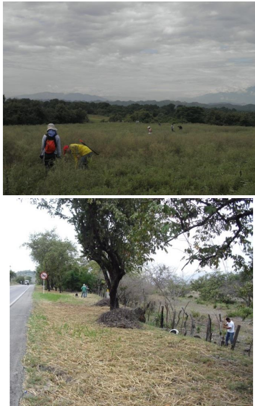
Figura 5. 175. Realización de pozos de sondeo cada 25 metros
