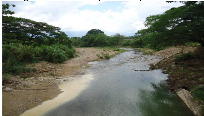
Figura 5-11: Afectación por erosión por socavación
