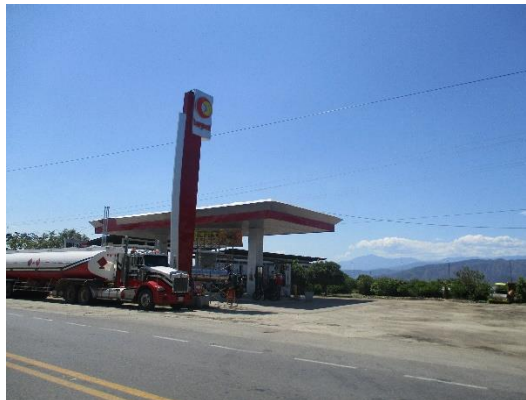
Figura 5-44 Fotografía estación de servicio
