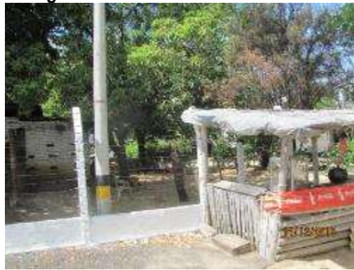
Figura 5-368. Registro fotográfico Construcción Habitacional Propietario Jorge Cadena
