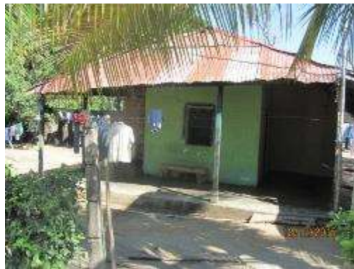
Figura 5-347. Registro fotográfico Construcción Habitacional Propietario Jairo Araque
