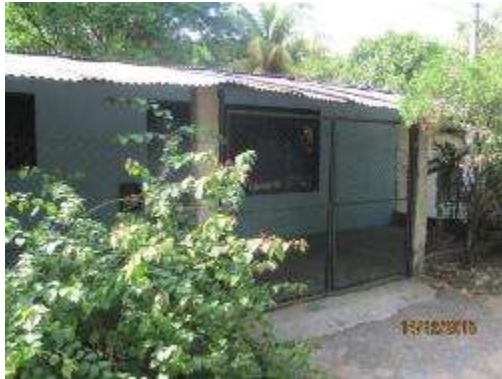
Figura 5-373. Registro fotográfico Construcción Habitacional Propietario Indeterminado
