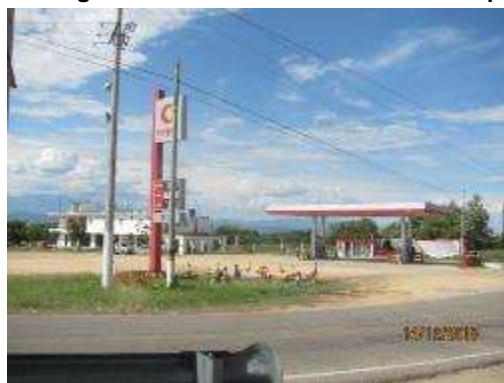
Figura 5-371. Registro fotográfico Construcción Comercial Propietario Indeterminado
