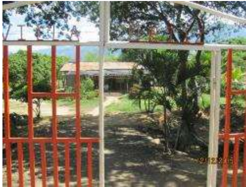
Figura 5-351. Registro fotográfico Construcción Habitacional Propietario Álvaro Tovar
