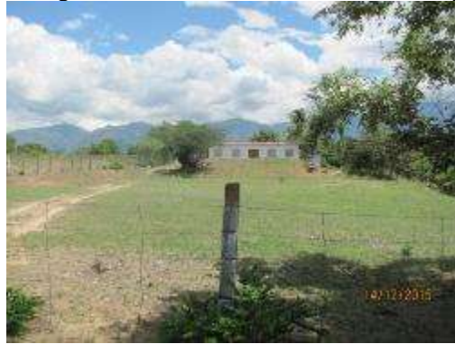
Figura 5-370. Registro fotográfico Construcción Habitacional Propietario Indeterminado
