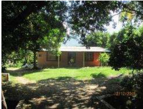
Figura 5-350. Registro fotográfico Construcción Habitacional Propietario Álvaro Tovar
