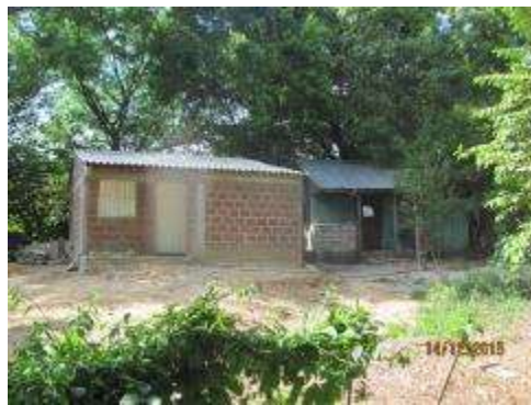
Figura 5-375. Registro fotográfico Construcción Habitacional Propietario Indeterminado
