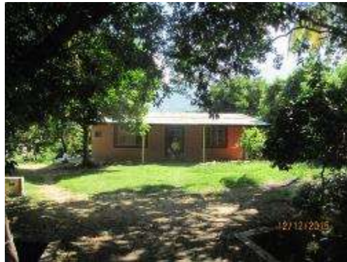
Figura 5-348. Registro fotográfico Construcción Habitacional Propietario Flor Dely Vieda Perdomo
