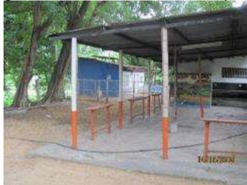
Figura 5-358. Registro fotográfico Construcción Habitacional Propietario Yamileth Reyes Murcia
