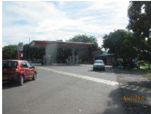
Figura 5-379. Registro fotográfico Construcción Comercial Propietario Ceagwdex del Huila S.A.
