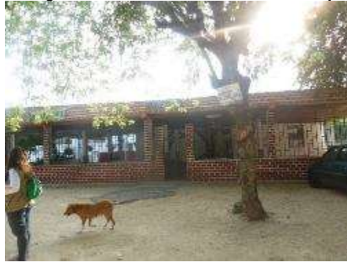
Figura 5-362. Registro fotográfico Construcción Comercial Propietario Sucesión García
