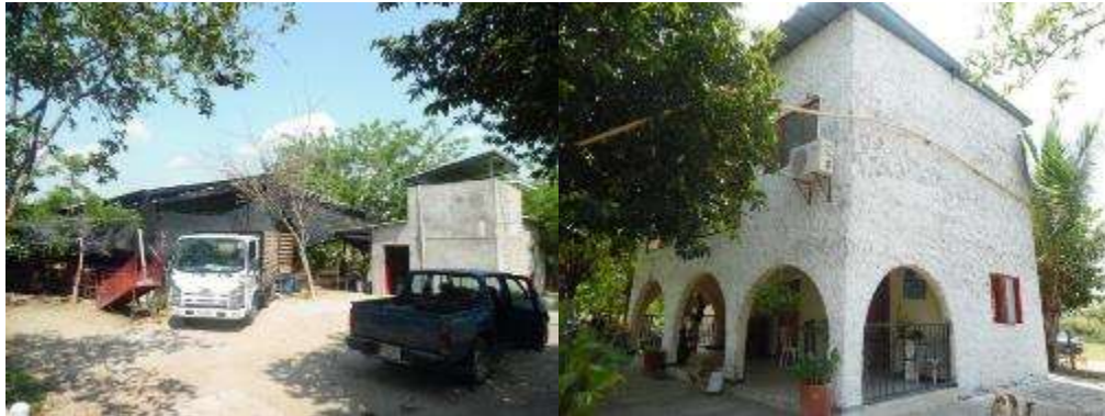
Figura 5-360. Registro fotográfico Construcción Habitacional Propietario José María de Videro Vergara
