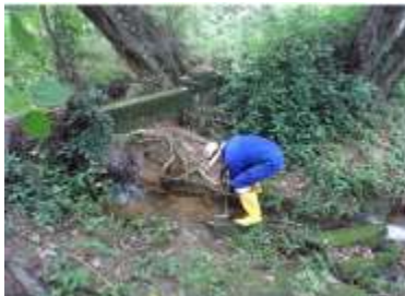
Figura 5-207 Quebrada La Dominga.
