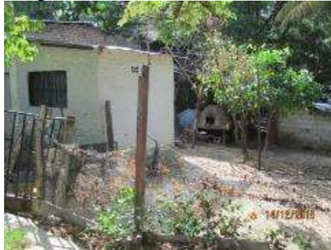
Figura 5-374. Registro fotográfico Construcción Habitacional Propietario Indeterminado
