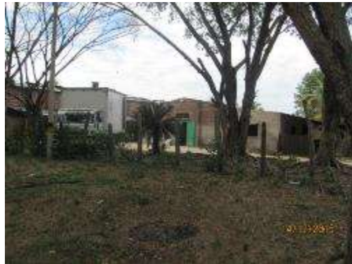
Figura 5-364. Registro fotográfico Construcción Habitacional Propietario Hugo Alberto Trujillo
