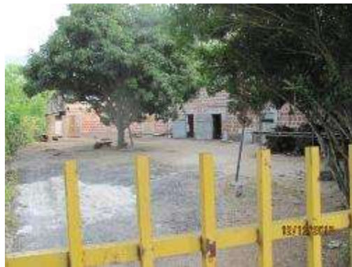
Figura 5-356. Registro fotográfico Construcción Habitacional Propietario Indeterminado
