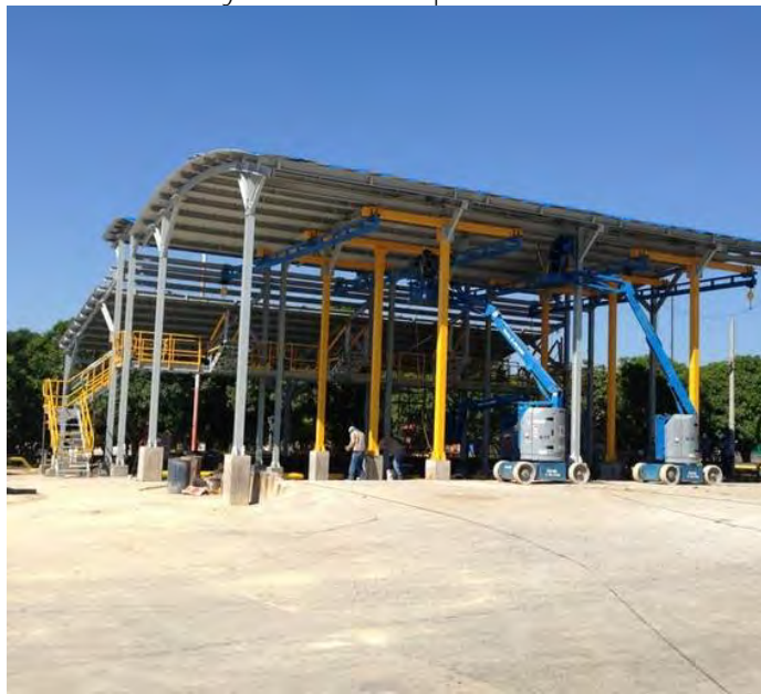
Figura 17. Estación de bombeo de Ayacucho - Ecopetrol
