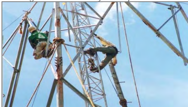
Figura 31. Ensamble y montaje de torres
