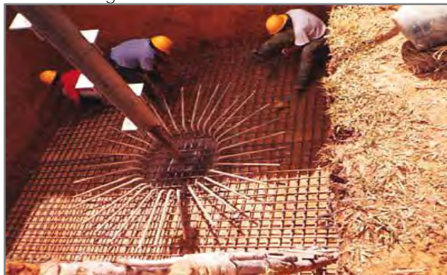
Figura 30. Cimentación de torres.
