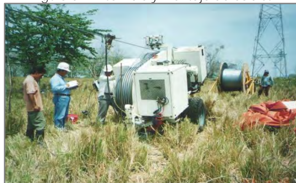
Figura 32. Ensamble y montaje de cables
