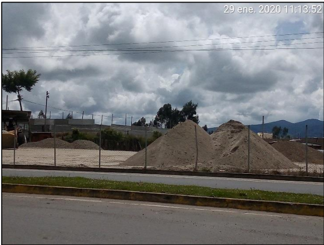
Fotografía 3-31 Acopio de materiales
