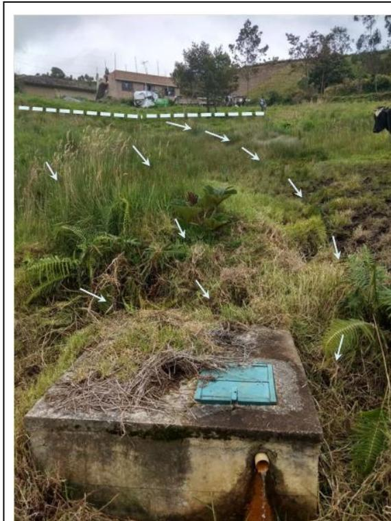
**Foto 36.** Comportamiento del flujo de agua proveniente de la parte alta de la ladera que alimenta la caja recolectora la cual vierte el agua para los drenajes intermitentes aguas abajo, en la actualidad no se utiliza debido a que los pobladores ya tienen acueducto. (Caja Abandonada)
