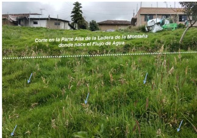
Foto 34. Se observa el corte en la montaña donde brota el agua a una zona húmeda donde los flujos drenan aguas abajo del área
