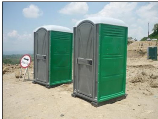
Fotografía 7.14 Baños portátiles Tipo.
