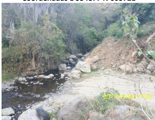
Fotografía 3.87 Punto de captación sobre la quebrada El Macal. Coordenadas E 954877 N 603721
