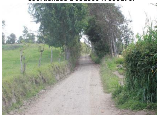
Fotografía 3.32 PK8+687. Tramo de vía en material granular con una calzada de 3.50 m de ancho. Coordenada E 951300 N 595176.
