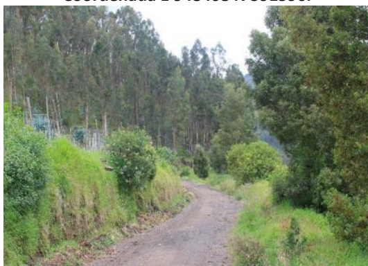
Fotografía 3.60 PK1+711. Tramo de vía en material con una calzada de 3.0 m de ancho. Coordenada E 948408 N 591596.
