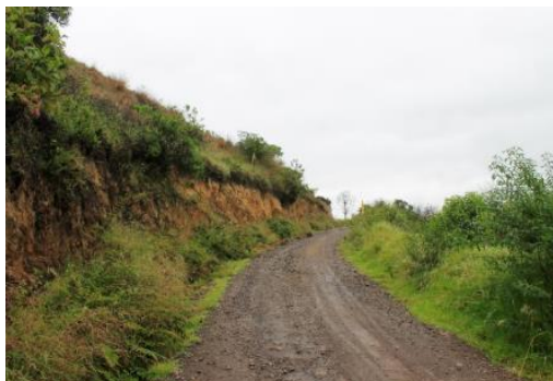
Fotografía 3.42 PK8+064. Tramo de la vía Ospina Pérez – Iles. Punto de cruce del Proyecto. Coordenada E 955613 N 597510.
