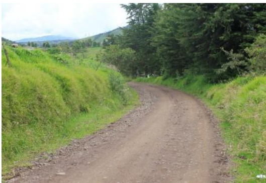
Fotografía 3.38 PK10+911. Tramo de vía en material granular con una calzada de 4.0 m de ancho. Coordenada E 954173 N 598736.
