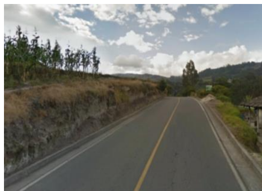
Fotografía 3.24 PK1+436. Tramo de vía en pavimento flexible, calzada de 6.00 m de ancho. Coordenada E 947999 N 591159.
