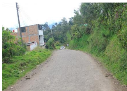
Fotografía 3.39 PK15+831. Tramo de vía en material granular con una calzada de 4.0 m de ancho. Coordenada E 950747 N 598821.
