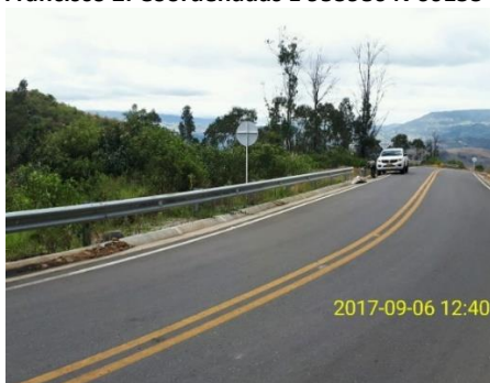
Fotografía 3.85 Punto de la vía de acceso a Iles donde se localiza la captación sobre la quebrada San Francisco 2. Coordenadas E 953986 N 601534
