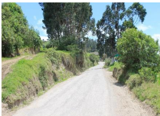
Fotografía 3.31 PK5+638. Tramo de vía en material granular, calzada de 3.50 m de ancho. Coordenada E 950140 N 594145.
