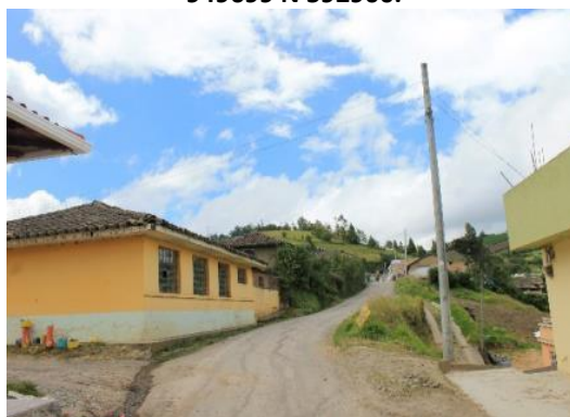
Fotografía 3.30 PK3+358. Tramo de vía en material granular, con una calzada de 4.50 m de ancho. Cercano al Centro Poblado del corregimiento Aldea de María – municipio Contadero. Coordenada E 949699 N 592900.
