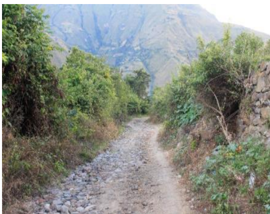
Fotografía 3.54 PK2+147. Tramo de vía en material granular con una calzada de 3.50 m de ancho. Coordenada E 954626 N 603780.
