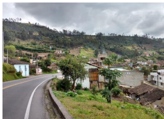
Fotografía 3.6 PK17+969. Centro Poblado del corregimiento de San Juan, municipio Ipiales. Coordenada E 947521 N 590391.
