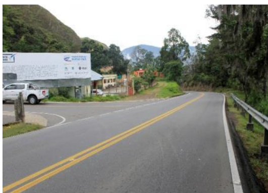
Fotografía 3.19 PK7+732. Cambio en las características de la vía. Pavimento flexible, con calzada de hasta 6.0 m de ancho, carece de señalización horizontal. Coordenada E 952902 N 601812.
