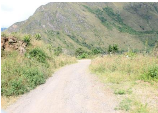
Fotografía 3.46 PK4+293. Tramo de vía en material granular con una calzada de 3.5 m de ancho. Coordenada E 954914 N 603811.
