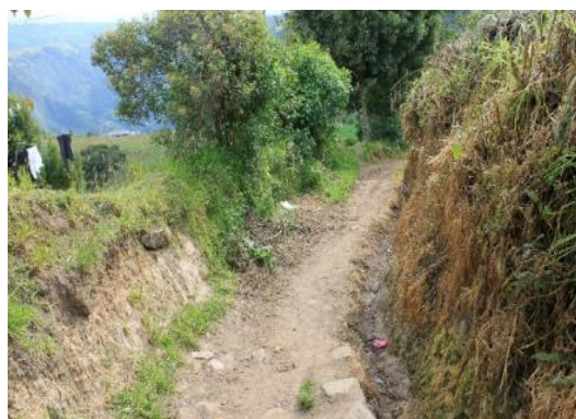
Fotografía 3.66 PK1+791. Tramo de vía – Sendero. Coordenada E 951760 N 594774.
