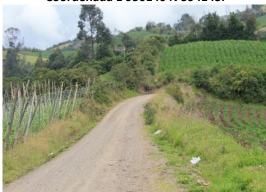
Fotografía 3.31 PK5+638. Tramo de vía en material granular, calzada de 3.50 m de ancho. Coordenada E 950140 N 594145.
