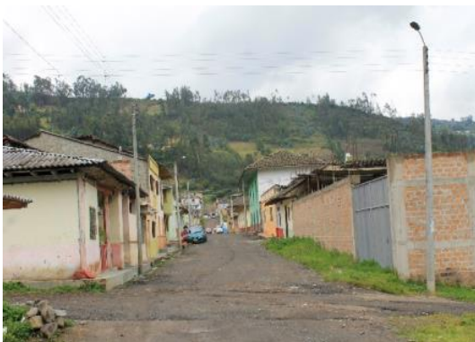
Fotografía 3.67 PK0+275. Tramo de vía interna del caserío San Juan – municipio Ipiales. Coordenada E 947635 N 590273.
