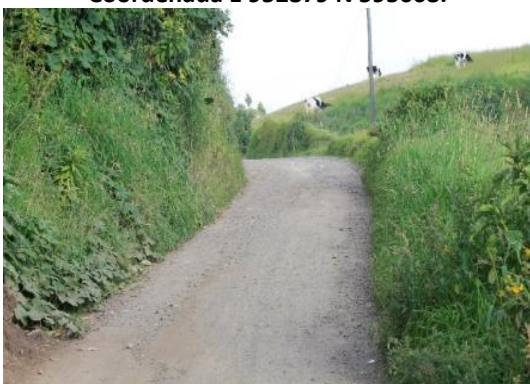
Fotografía 3.63 PK0+069. Tramo de la vía de acceso a Ospina Pérez. Punto donde el Proyecto Vial Doble Calzada Rumichaca -Pasto, Tramo San Juan – Pedregal cruzará la vía. Coordenada E 952879 N 595608.
