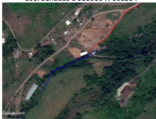
Fotografía 3.88 Vista planta de zona de parqueo para la captación sobre quebrada El Macal. Coordenadas E 953986 N 601534
