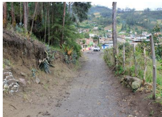
Fotografía 3.68 PK0+382. Tramo de vía en material granular con una calzada de 3.50 m. Coordenada E 947658 N 590169.
