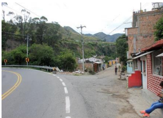
Fotografía 3.48 PK0+000. Punto de origen de la vía. Coordenada E 955489 N 604929.
