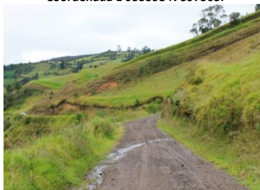
Fotografía 3.41 PK7+813. Tramo de la vía Ospina Pérez – Iles. Punto de cruce del Proyecto. Coordenada E 955398 N 597503.
