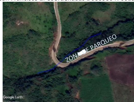
Fotografía 3.86 Vista en planta de la zona de parqueo para la captación sobre quebrada San Francisco 2. Coordenadas E 953986 N 601534
