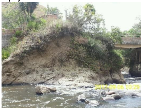
Fotografía 3.89 Punto de capitación sobre el río Sapuyes. Coordenadas E 954817 N 605100
