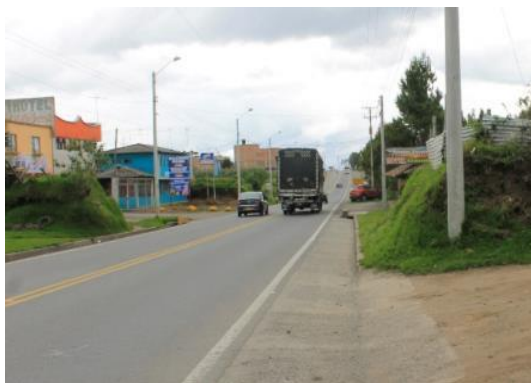
Fotografía 3.3 PK8+197. Tramo de vía en pavimento flexible, calzada de 7.30 m de ancho. Coordenada E 941776 N 583913.
