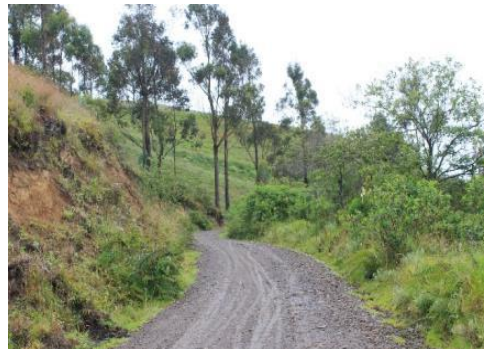
Fotografía 3.43 PK8+150. Tramo de la vía Ospina Pérez – Iles. Punto de cruce del Proyecto. Coordenada E 955662 N 597500.
