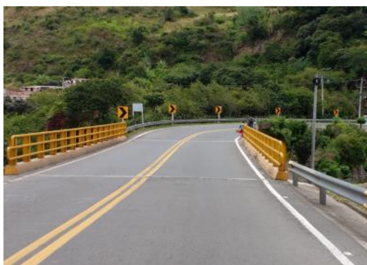
Fotografía 3.15 PK41+700. Punto donde se construirá intercambiador de Pilcuán Coordenada E 955471 N 604839.
