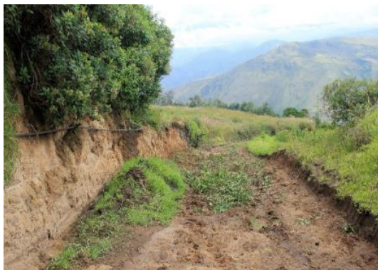
Fotografía 3.74 PK0+683. Estado de talud. Coordenada E 954883 N 601307.
