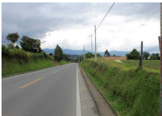
Fotografía 3.5 PK11+186. Tramo de vía en pavimento flexible, calzada de 7.30 m de ancho. Coordenada E 943685 N 585979.
