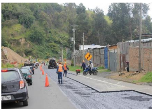
Fotografía 3.11 PK79+808. Actividades de mantenimiento correctivo sobre la vía – Reparcho. Coordenada E 976375 N 621159.
