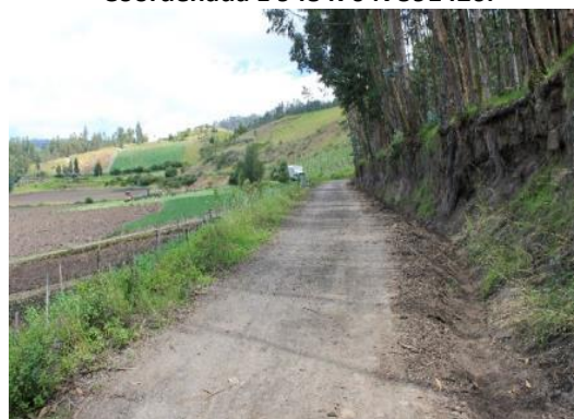
Fotografía 3.61 PK1+897. Tramo de vía en material granular con una calzada de 3.0 m de ancho. Coordenada E 948470 N 591426.
