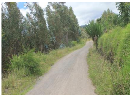
Fotografía 3.59 PK1+206. Tramo de vía en material granular con una calzada de 3.0 m de ancho. Coordenada E 948044 N 591646.
