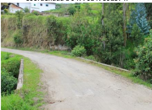
Fotografía 3.58 PK0+306. Puente en concreto reforzado con tablero de 4.5 x 7.5 m. Coordenada E 947761 N 592374.
