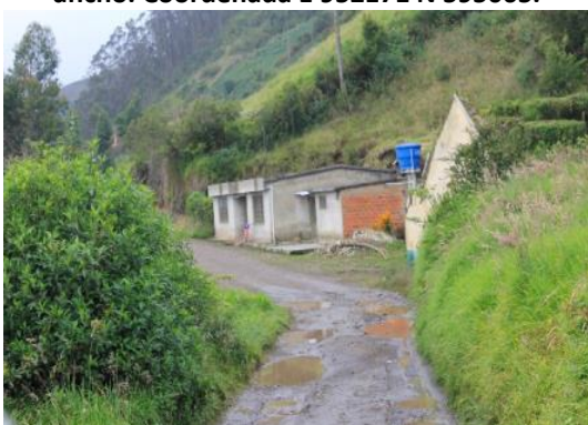
Fotografía 3.65 PK1+181. Tramo de vía en material granular con una calzada de 2.50 m de ancho. Coordenada E 952171 N 595065.
