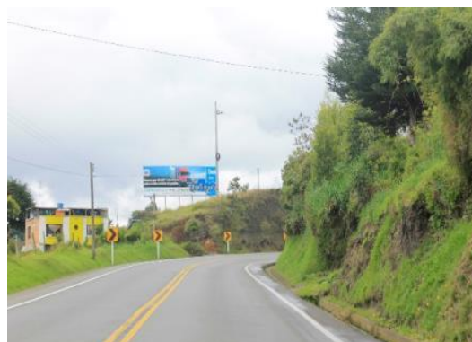
Fotografía 3.10 PK71+567. Tramo de vía en pavimento flexible, calzada de 7.30 m de ancho. Coordenada E 970413 N 618469.
