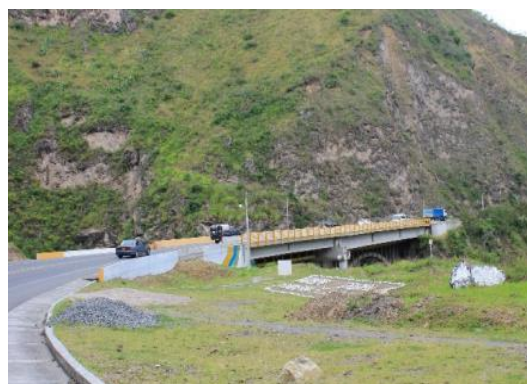
Fotografía 3.8 PK46+489. Puente sobre el río Guáitara. Coordenada E 958730 N 608627.
