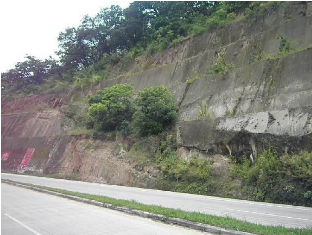
Foto N° 8.9 Muestra un fallamiento local, tipo inverso, en una secuencia piroclástica, en corte de CA-1 pocos metros antes de llegar al puente Aguacapa,
