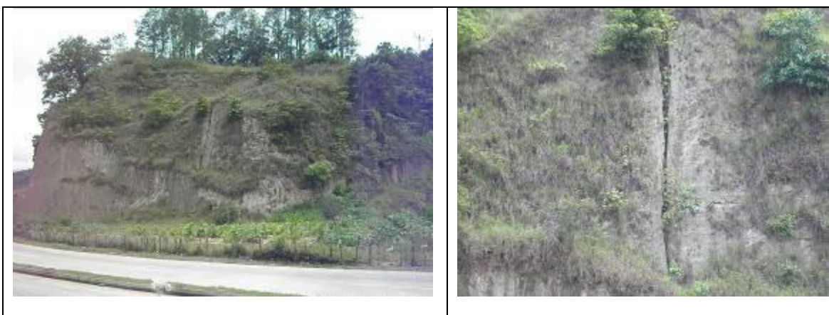
Foto N° 8.12 – 8.13 Banco de préstamo de material piroclástico a orillas de la CA-1 (izquierda) con indicios de procesos erosivos (derecha).
