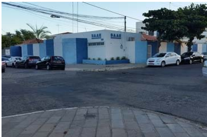
Foto 5.3-3: Sede da SAAE em Juazeiro localizada a R. Barão de Cotegipe, 1 – Centro.
